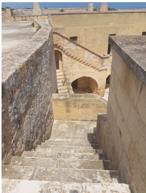
Fig. 3. Scalinate di raccordo tra i camminamenti di ronda, gli alloggi dei militari situati nelle maniche dell'Opera a Corno e la piazza d'armi.
