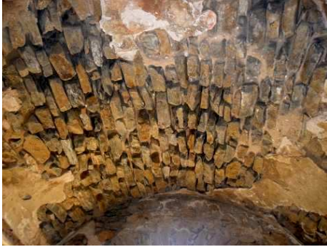
Fig. 4. La maçonnerie des voûtes en berceau (Auteur, 2012).
