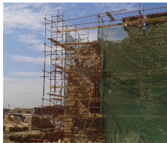
Fig. 6 : L'angle du parapet disloqué, avant en cours et après confortement (Auteur, 2012 et 2016).
