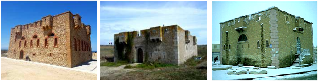
Fig. 2. Le prototype “corps de grade crénelés type 1846”. Gauche : Le fort Bordj Istanbul, Alger, Algérie (Auteur, 2012). Centre : Le réduit “type 1846”, de Belle-île-en mer, France ( http://a54.idata.over-blog.com/0/12/33/28/Belle-île-en-Mer/Belle-île-454-.jpg ). Droite : Le fortin Bruyès, Djelfa, Algérie ( https://i0.wp.com/cciondjelfa.com/ar/wpcontent/uploads/2014/03/djelfa-new-3.jpg?resize=300%2C225 ).
