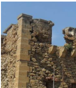
Fig. 6 : L'angle du parapet disloqué, avant en cours et après confortement (Auteur, 2012 et 2016).
