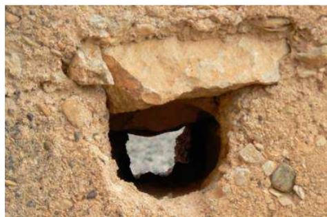
Fig. 3. Mechinal en tapia con remate superior de mampuesto de piedra caliza (J. Fernández-del-Toro).
