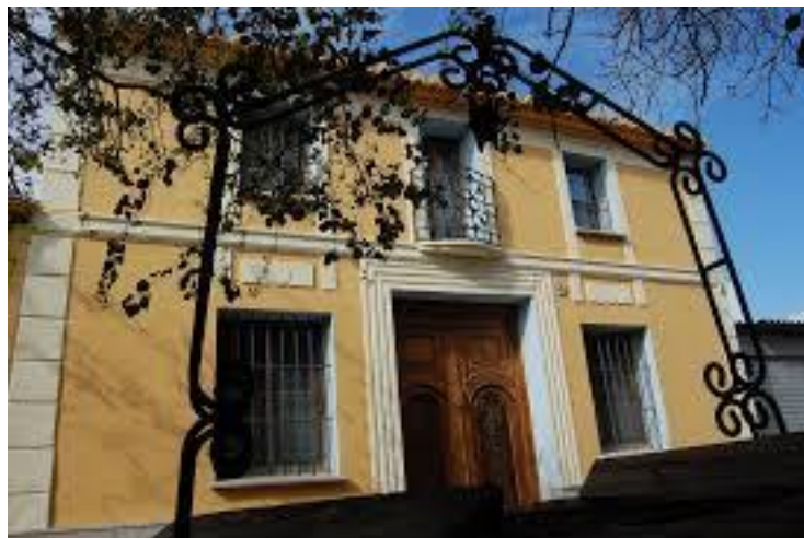
Ilustración 2: Fachada principal del edificio 9A.
