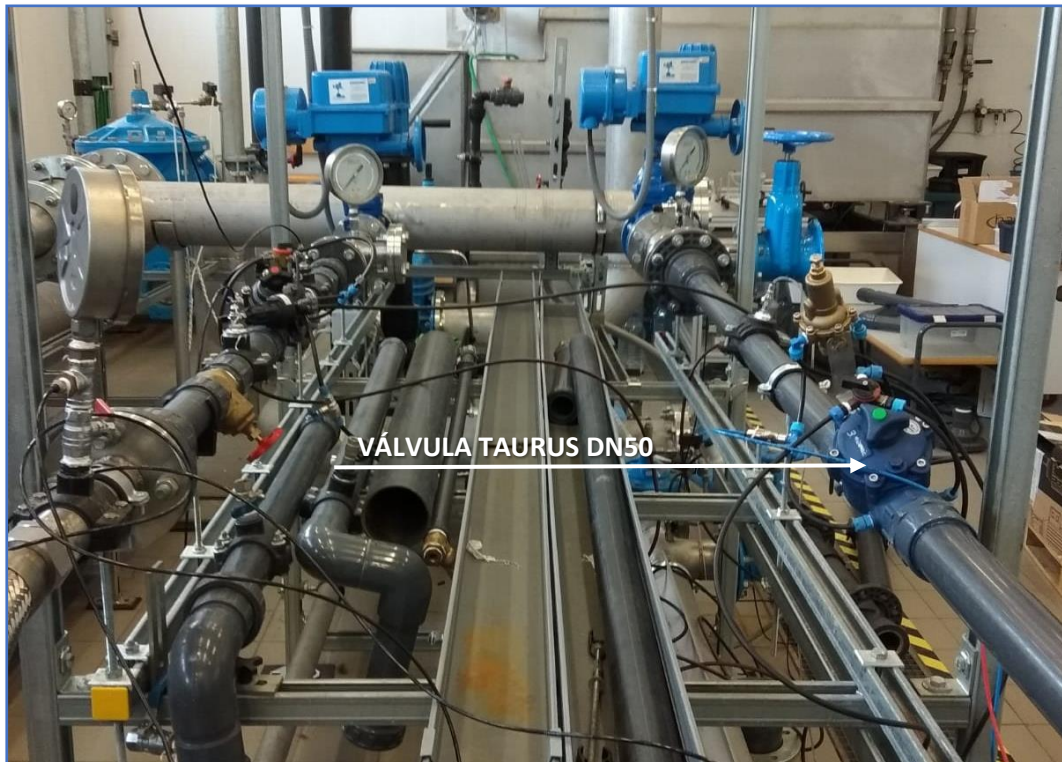
Ilustración 11 : Línea de ensayo utilizada con la válvula TAURUS conectada
