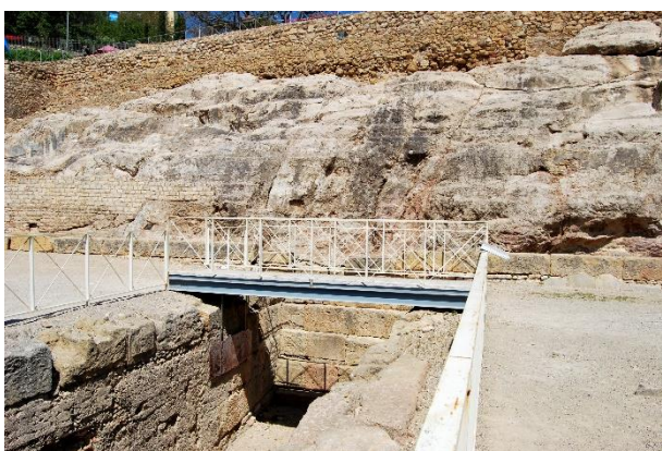
Figura 16: Fotografía del estado actual de los santuarios del anfiteatro de Tarraco.
