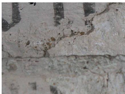
Figura 39. Detalle de las capas de guarnecido en las cuales se aprecia las características formales de los áridos.
