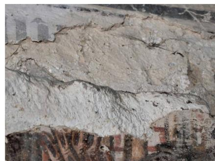
Figura 40. Detalle de las capas de guarnecido.
