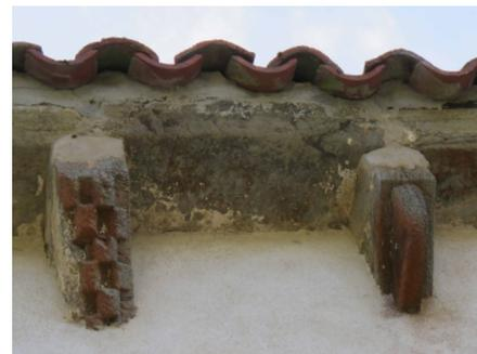
Figura 4. Canecillos del muro norte con restos de película pictórica.
