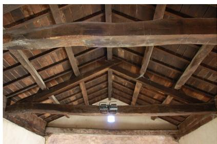
Figura 2. Armadura de madera a dos aguas.
