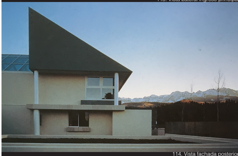
114. Vista fachada posterior
