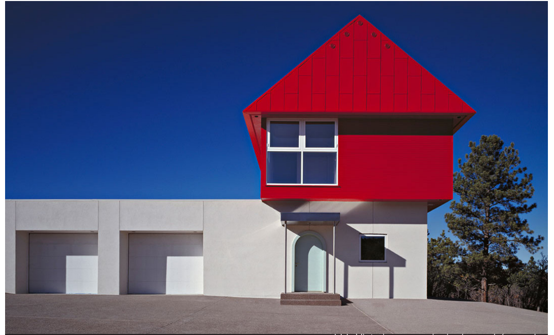
111. Vista ingreso principal casa huéspedes
