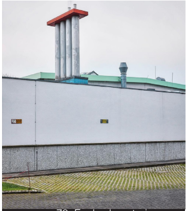
70. Fachada exterior muro
