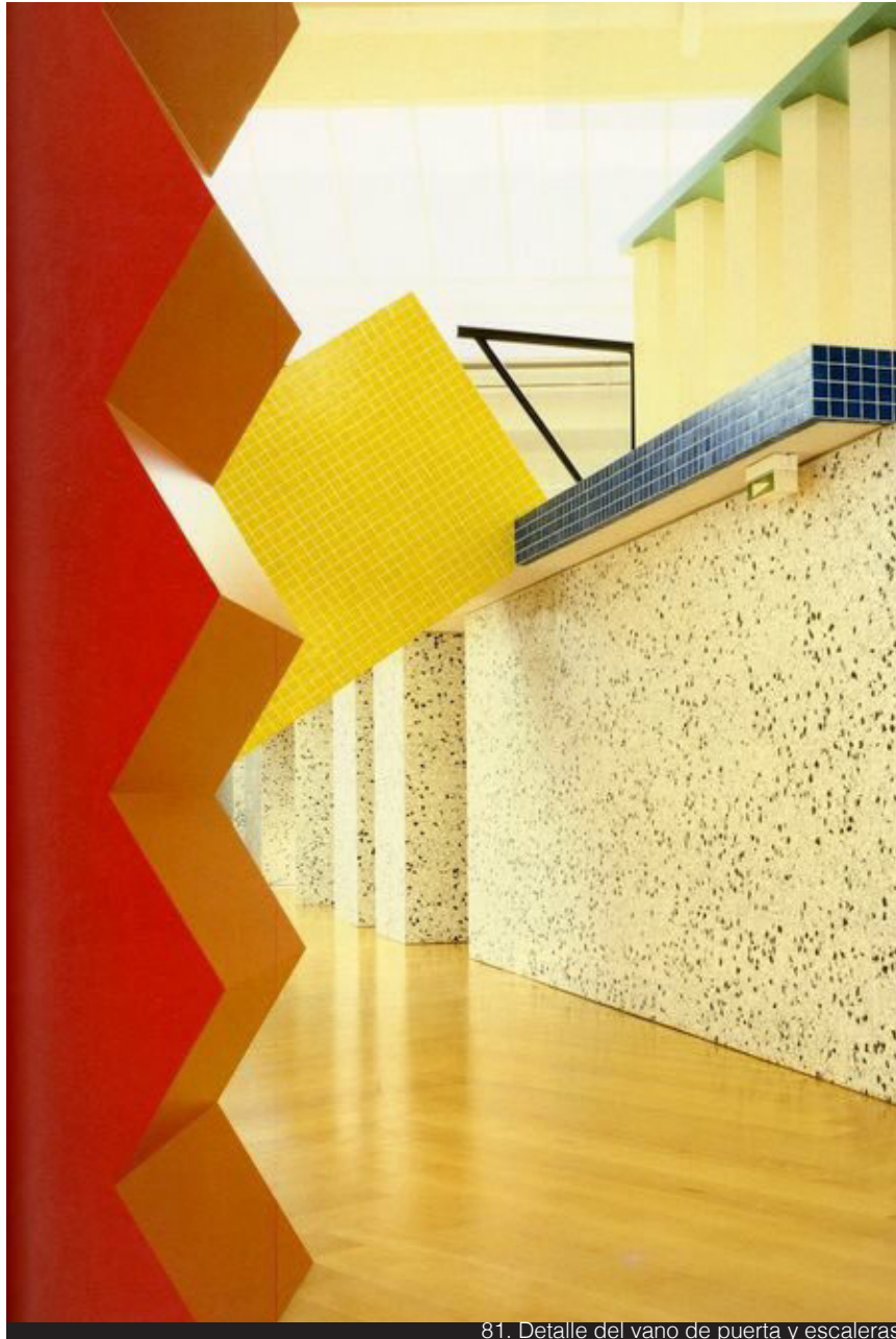
81. Detalle del vano de puerta y escaleras
