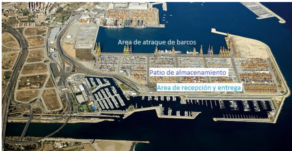
Figura 1: Terminal marítimo de contenedores en el puerto de Valencia
