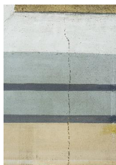
Fig. 139. Grieta película pictórica en San Gregorio.
