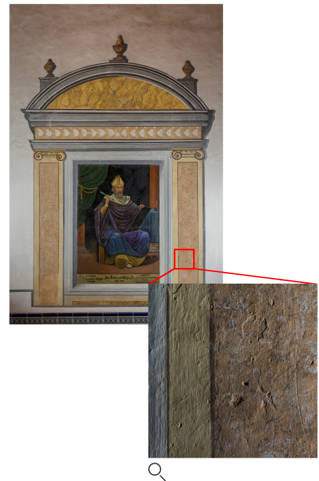
Fig. 115. Sección de extracción de muestras San Ambrosio.
