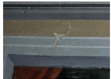
Fig. 132. Pérdida de película pictórica y escamas levantadas alrededor del trampantojo San Agustín.
