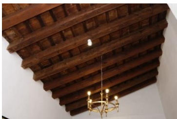
Fig. 46. Techumbre tras la restauración.
