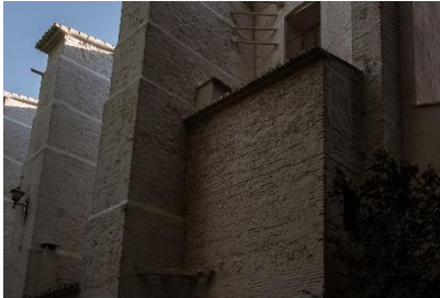
Fig. 99. Detalle muro exterior.
