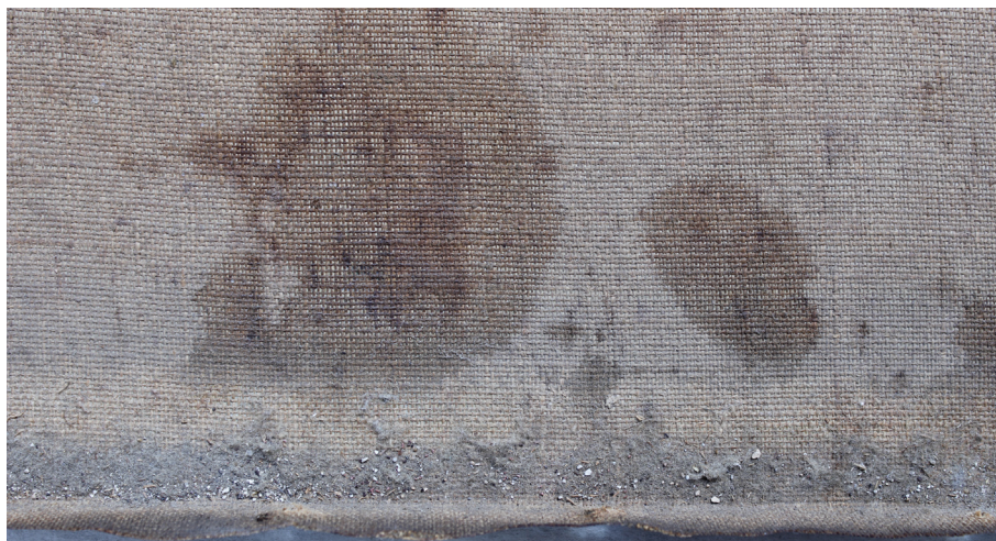
Fig. 45. Suciedad acumulada en la parte inferior.
