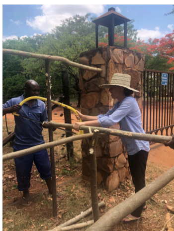
Fig. 35. Construcción del Monumento a la Permacultura. Blankenstein, H. 2019 [Fotografía]
