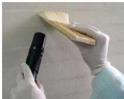
Figura 48.- Retirar la suciedad superficial mediante brocha y aspiración.
