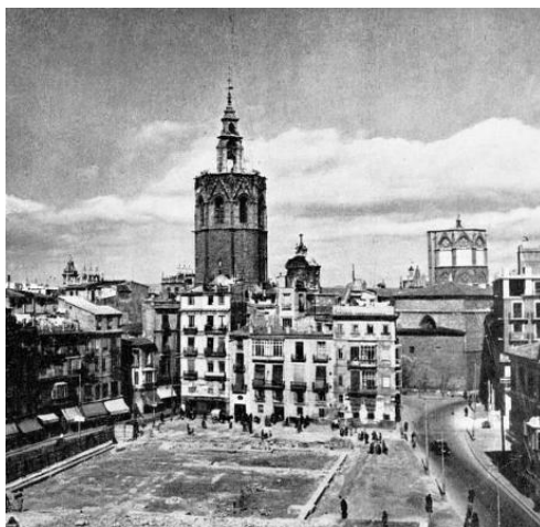
Figura 13.- Construcción de la Plaza de La Reina, 1878
