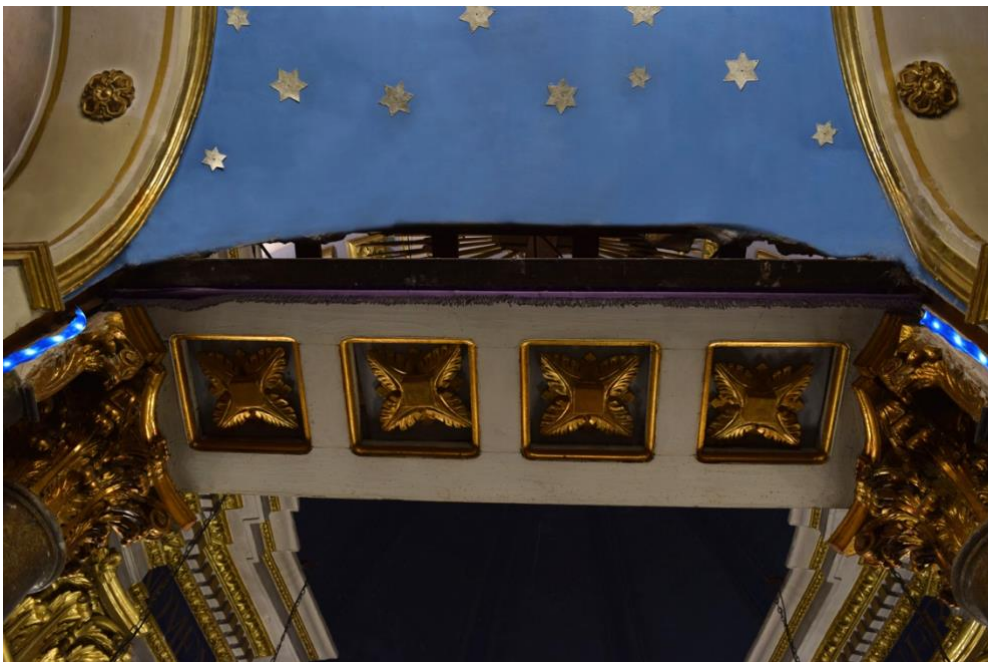
Después: Instalación eléctrica con leds a los laterales
