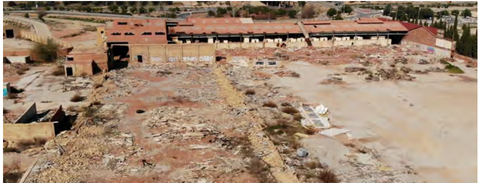
Fig. 154. Fotografía tomada con dron.
