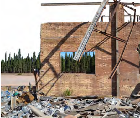
Fig. 147. Fotografía del muro.
