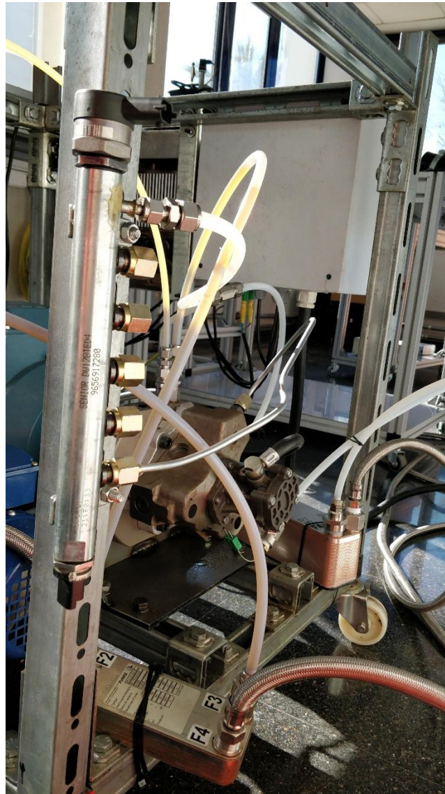
105. 3 fase de construcción. Sistemas common rail y transporte del fuel a la maqueta
