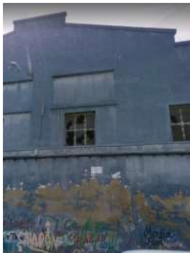
Fig.35. Fotografía parcial de la fachada del edificio en el que se localiza la obra realizada en 2008.
