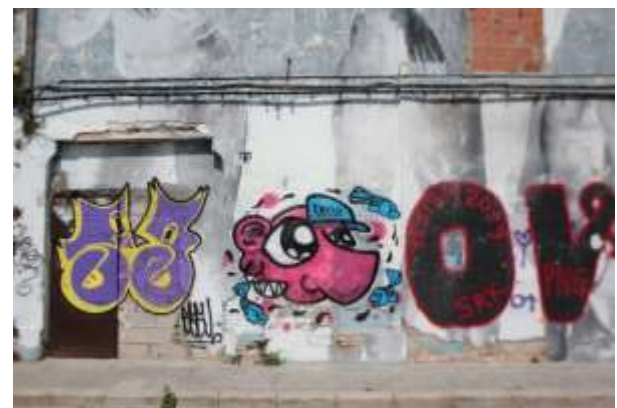
Fig.22. Detalle de puerta y parte de la zona inferior.
