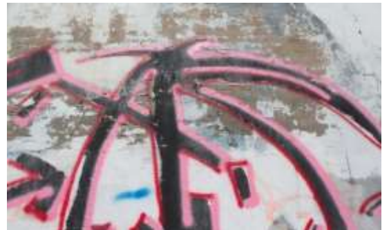
Fig. 49. Daños causados por capilaridad del agua.
