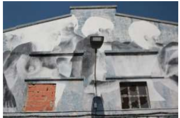
Fig.20. Detalle de zona central.
