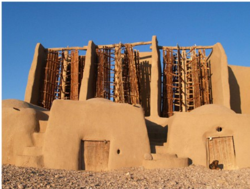
Figura 2.1: Molino de viento primitivo (Persia, siglo VII d.C.). Imagen extraída de [2]
