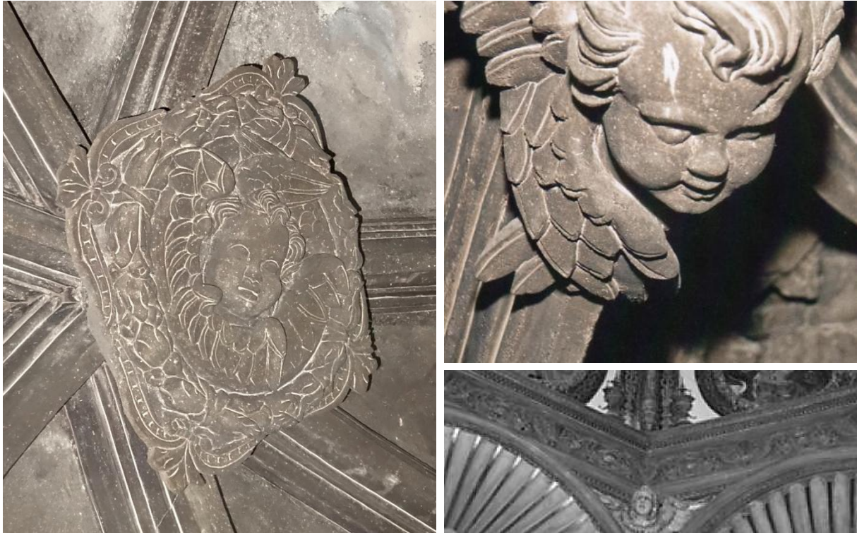
Figura IV.98. Clave central de la bóveda protorrenacentista de la Capilla de la Comuni3n, Algemesi (izq.).
