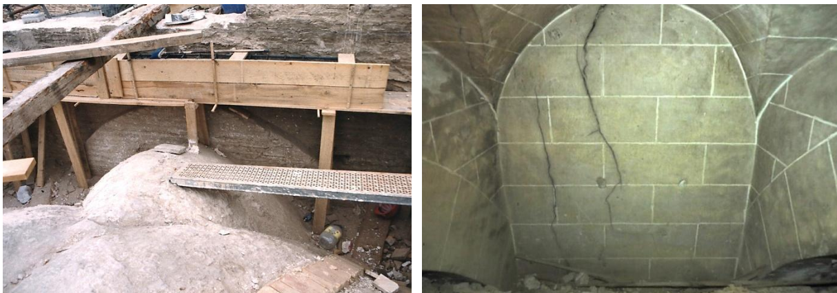
Figura IV.72. Intervención en la cubierta de la Capilla de la Comunión, gracias a la cual pudo esclarecerse el enigma relativo a las bóvedas; al fondo se distinguen las marcas de una bóveda anterior (izq.). Bóveda de la capilla lateral central, sita en el lado derecho, donde destaca la diferencia de nivel entre arranques (der.).
