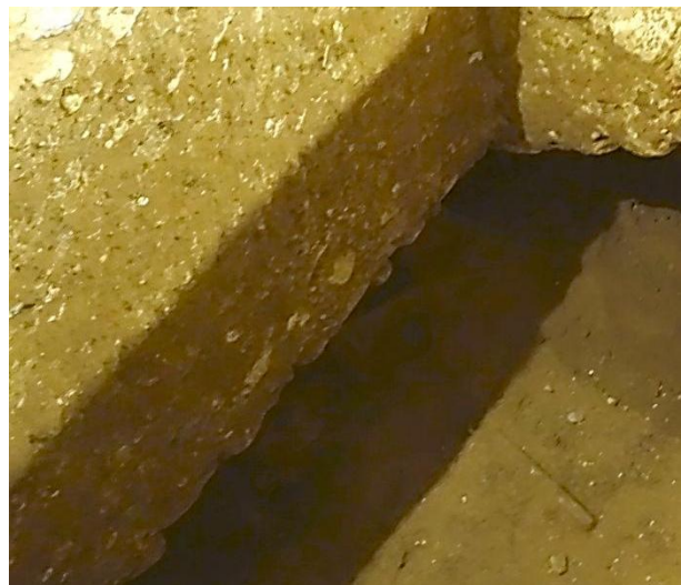
Figura IV.38. Cimentación muro de tapia perimetral.
