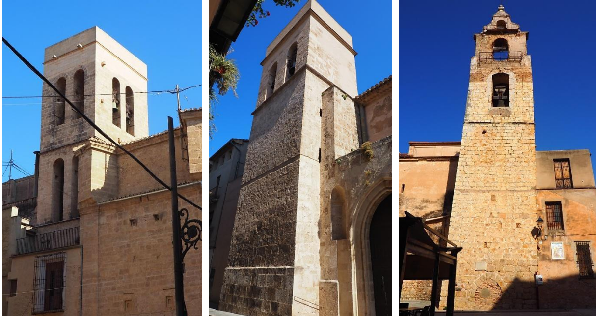
Figura IV.47. Campanario iglesia Santísimo Cristo del Salvador, Valencia (izq.). Campanario iglesia San Pedro, Xàtiva (centro). Campanario antigua iglesia Santa Catalina, Alzira (der.).
