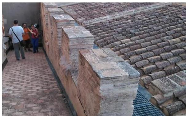
Figura IV.78. Almenas, parcialmente, reconstruidas.
