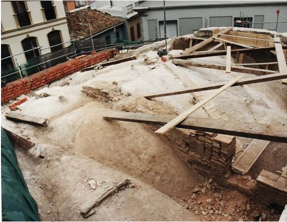
Figura IV.90. Reconstrucción de la cubierta; el trasdós que se observa en la fotografía corresponde a las bóvedas del siglo XVI (izq.). Espacio comprendido entre la bóveda del siglo XVI y el revestimiento rococó que envuelve la actual Capilla de la Comunión; en la imagen destaca el derrumbe del nervio encargado de conectar los arcos formeros (der.).
