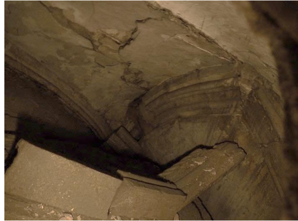
Figura IV.90. Reconstrucción de la cubierta; el trasdós que se observa en la fotografía corresponde a las bóvedas del siglo XVI (izq.). Espacio comprendido entre la bóveda del siglo XVI y el revestimiento rococó que envuelve la actual Capilla de la Comunión; en la imagen destaca el derrumbe del nervio encargado de conectar los arcos formeros (der.).
