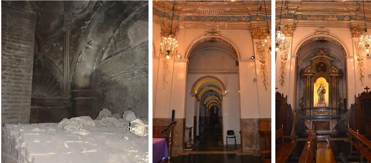
Figura IV.129. Espacio interbóveda comprendido por la excepcional bóveda de principios siglo XVI y la envoltura tabicada del siglo XVIII; a la derecha de la imagen, el tabique que conforma el paramento al que se adhiere el ornato perimetral de la nave (izq.). Vano absidal de conexión entre la Capilla de la Comunión y la basílica (centro). Una de las capillas del flanco izquierdo cuya estructura original fue erigida en el siglo XIV–XV; siendo, además, una de las dos que rebajaron considerablemente su altura primitiva (der.).
