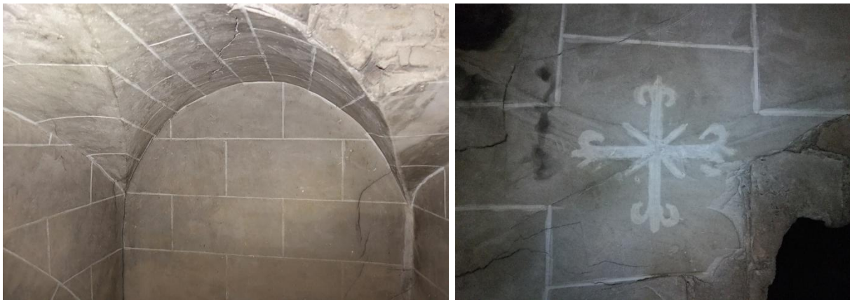
Figura IV.95. Arranque bóveda arista, sita en la capilla central del lado de la epístola (izq.). Vértice central de la citada bóveda de arista (der.).
