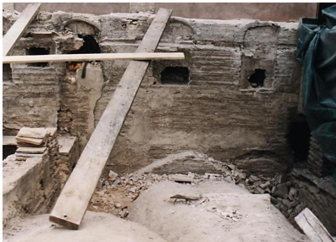
Figura IV.74. Techumbre abovedada —fase 3, siglo XVI— correspondiente a la crujía contigua al ábside; al fondo los restos de una bóveda precedente de trazo apuntado.
