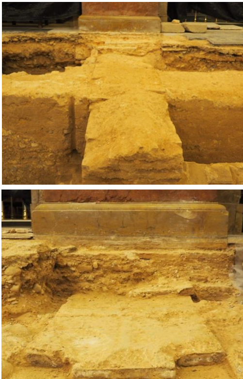
Figura IV.68. Cimentación iglesia siglo XIV–XV, correspondiente al lado derecho del templo; al fondo se observa como la nueva estructura apoya, directamente, sobre los vestigios de la iglesia del siglo XIII. (izq. sup.). Detalle del encuentro entre el arco diafragma que sirve de base y el nuevo muro (izq. inf.). Plano que atestigua la reutilización del templo primitivo como parte de la cimentación de la iglesia del siglo XIV–XV (der.).
