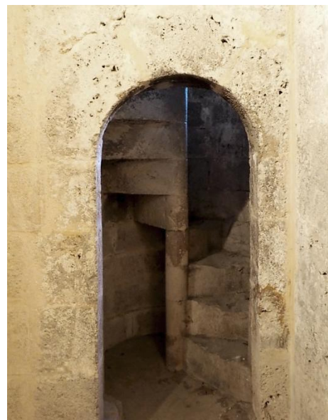
Figura IV.50. Escalera torre campanario iglesia San Pedro, Xàtiva.
