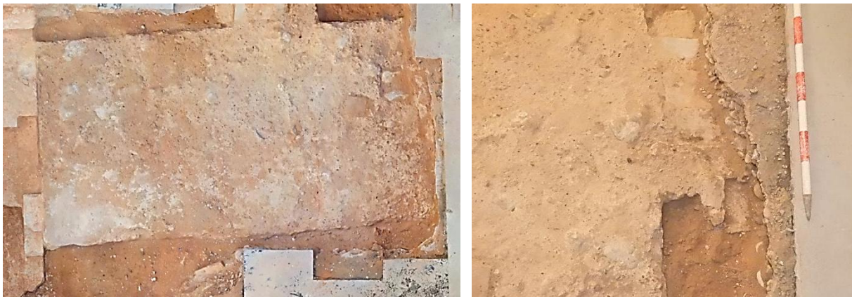
Figura IV.49. Muro lateral campanario siglo XIII, cuyo fondo se servía del contrafuerte del arco diafragma para cerrar la estructura (izq.). Ladrillos empotrados en la tapia del campanario (der.).
