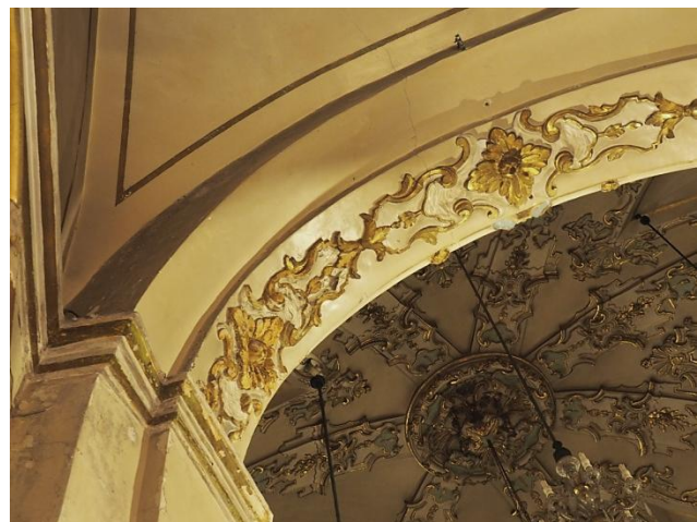
Figura IV.110. Cara interna del arco que da acceso a la primera capilla absidial del lado del evangelio.
