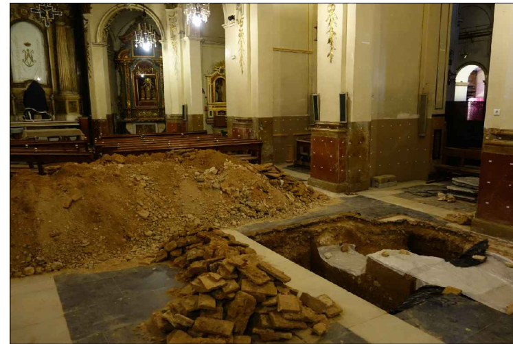
SONDEO 1: acopio ladrillos sondeo 1, acopio losas pavimento.
