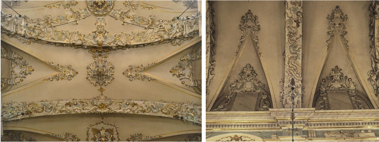
Figura IV.123. Porción bóveda de cañón nave (izq.). Lunetos bóveda nave (der.).
