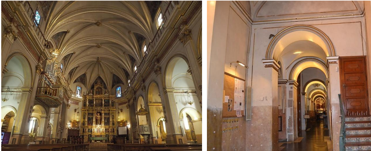
Figura III.11. Interior basílica menor de San Jaime Apóstol de Algemesí (izq.). Arcos de conexión entre las capillas del lado de la epístola (der.).
