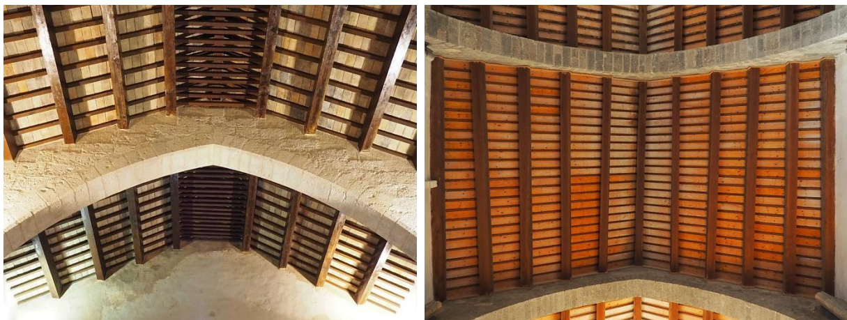
Figura IV.40. Techumbre ermita de San Roque de Ternils, Carcaixent (izq.). Techumbre iglesia del Salvador, Sagunto (der.)
