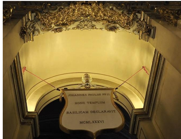
Figura IV.125. Bóveda de cañón de uno de los vanos que sirven de enlace entre ambas iglesias.
