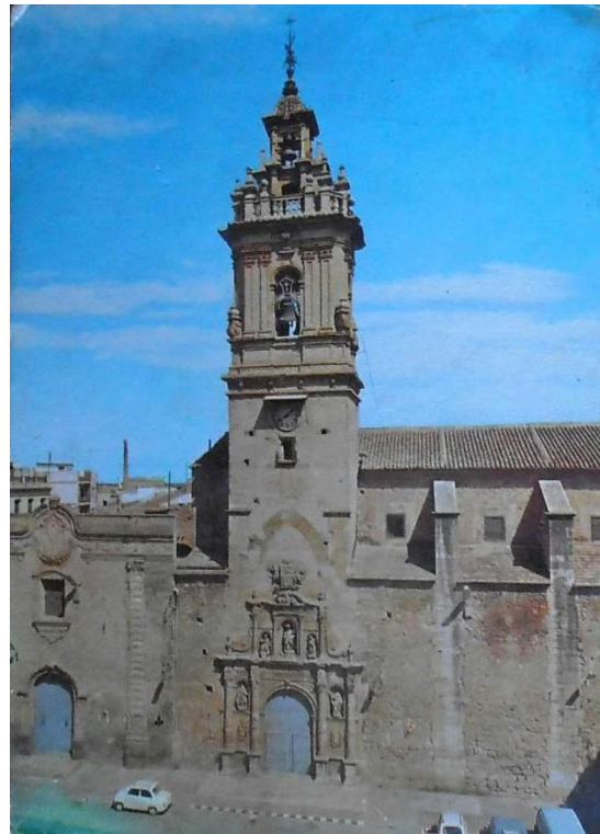
Figura III.9. Vista frontal del campanario de la basílica menor de Algemés, en la década de los sesenta del pasado siglo.
