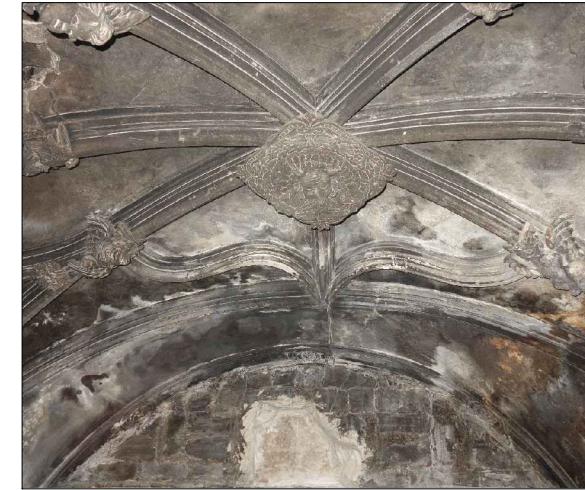
Bóveda de crucería protorenacentista (1)
