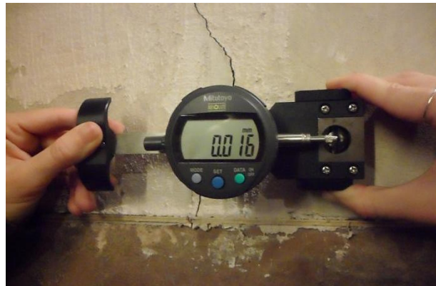
Figura V.36. Fisurómetro digital utilizado.
