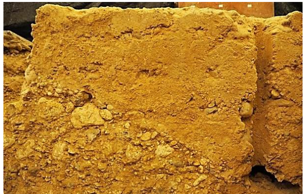
Figura IV.55. Porción de la tapia en donde puede apreciarse tanto el acabado como el material que conforma el muro.
