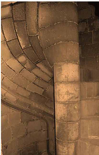
Figura IV.52. Escalera de caracol abovedada en la torre norte del transepto de la catedral de Barcelona (izq.). Escalera de caracol de planta cuadrada en el campanario de la iglesia de la Sangre, Onda (der.).
