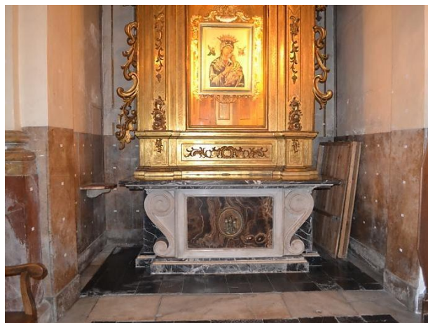
Figura V.24. Zócalo marmóreo que circunda las capillas laterales.
