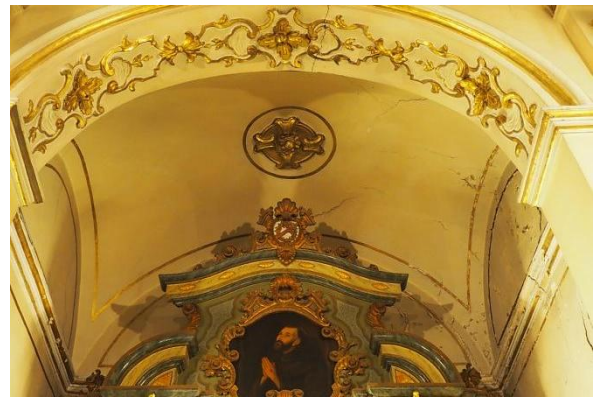
Figura IV.126. Bóvedas baídas, de diferente traza, que cierran superiormente las capillas laterales.
