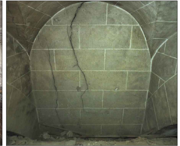
Bóveda de arista (2)
