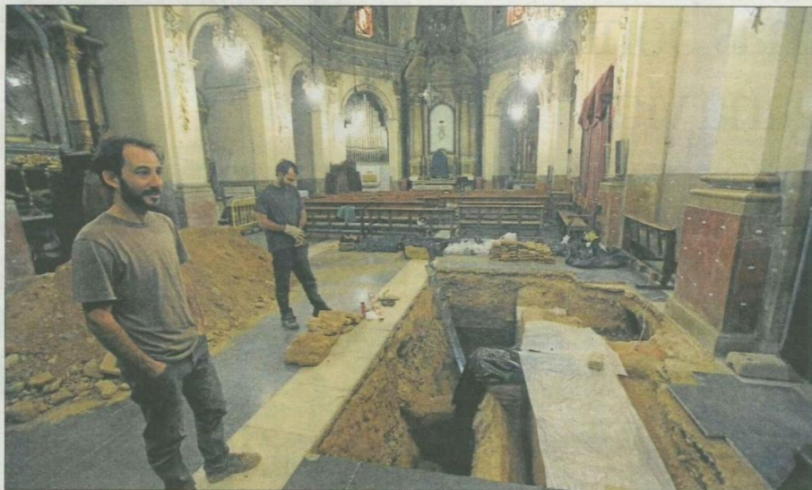
Excavaciones en la Capella de la Comunió de la Basílica de Sant Jaume de Algemesi, realizadas por la Politècnica de València. VICENT M. PASTOR
