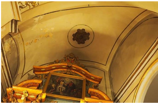
Figura IV.126. Bóvedas baídas, de diferente traza, que cierran superiormente las capillas laterales.
