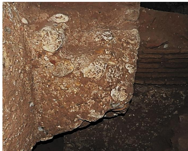
Figura IV.37. Zapata de uno de los arcos diafragma, con recorte diagonal practicado a posteriori.
