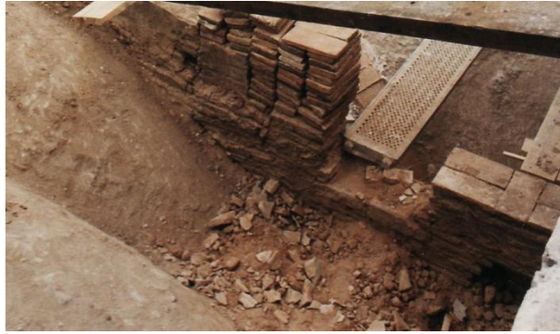
Figura IV.105. Relleno riñones bóveda nave principal.
