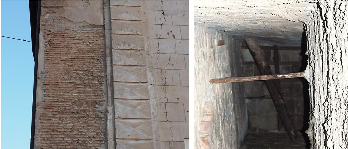
Figura IV.115. Esquina izquierda de la portada de la Capilla de la Comunión, en la cual queda al descubierto el ladrillo empleado para completar la franja trabada a la fachada que, en la anterior fase constructiva, se erigió en tapia valenciana (izq.). Vacío que resta entre el muro de fachada —a la izquierda de la imagen— y el revestimiento rococó —a la derecha de la imagen— en donde, al fondo, se vislumbra la techumbre de la primera capilla izquierda y la inexistencia de un sistema abovedado anterior a la bóveda actual (der.).
