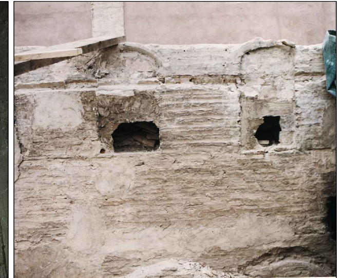
Almenas y huellas de unas bóvedas anteriores (2)
