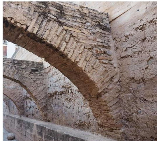
Figura IV.34. Paso de ronda de la muralla islámica de Alzira.
