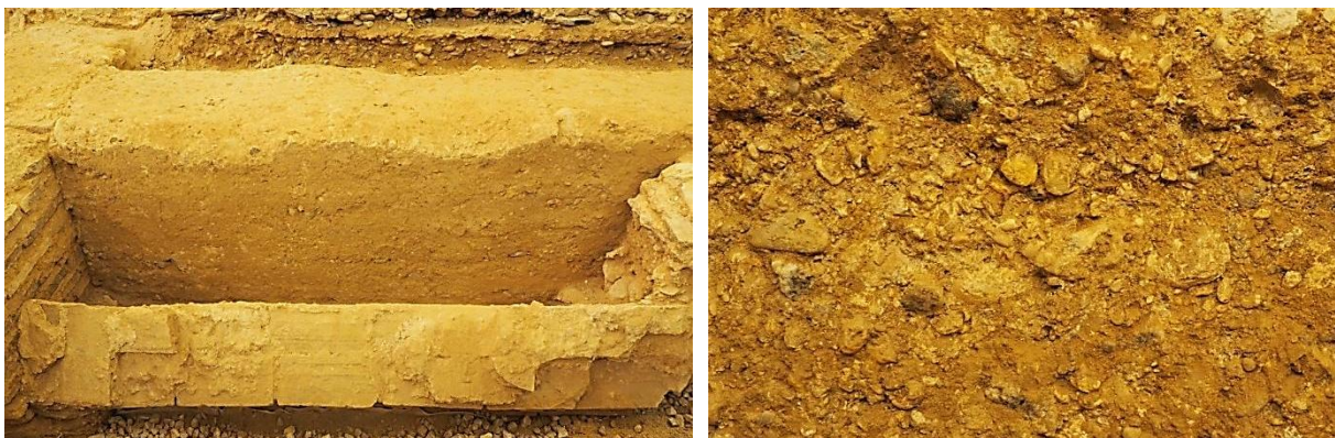
Figura IV.32. Muro perimetral de tapia en el que puede verse, además, el arranque de bóveda de una cripta posterior (izq.). Detalle de la tapia hormigonada en la iglesia del siglo XIII de Algemés (der.).
