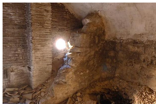
Figura IV.107. Muro perimetral de la basílica, que pervive inacabado en la zona bajocubierta de la Capilla de la Comunión.
