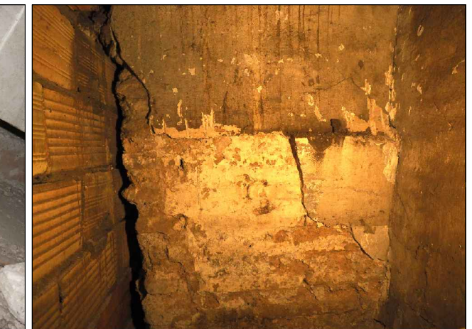
Muro de mayor espesor (4)
