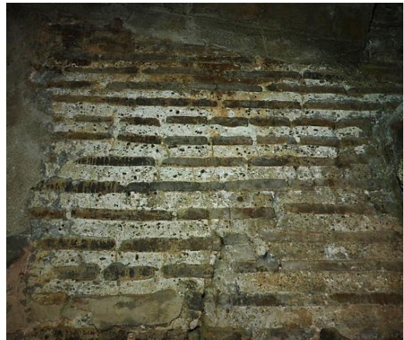
Figura IV.82. Muro de la iglesia del siglo XIV-XV, ubicado en la galería bajocubierta derecha.
