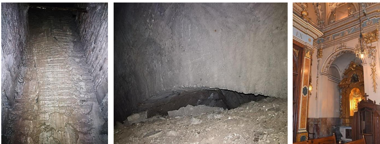
Figura IV.130. Arco formero practicado —en la fase 5— para abrir la capilla izquierda junto a la entrada (izq.). Encuentro entre dicho arco y el trasdós de la bóveda tabicada que cierra superiormente la capilla (centro). Primera capilla del lado del evangelio (der.).
