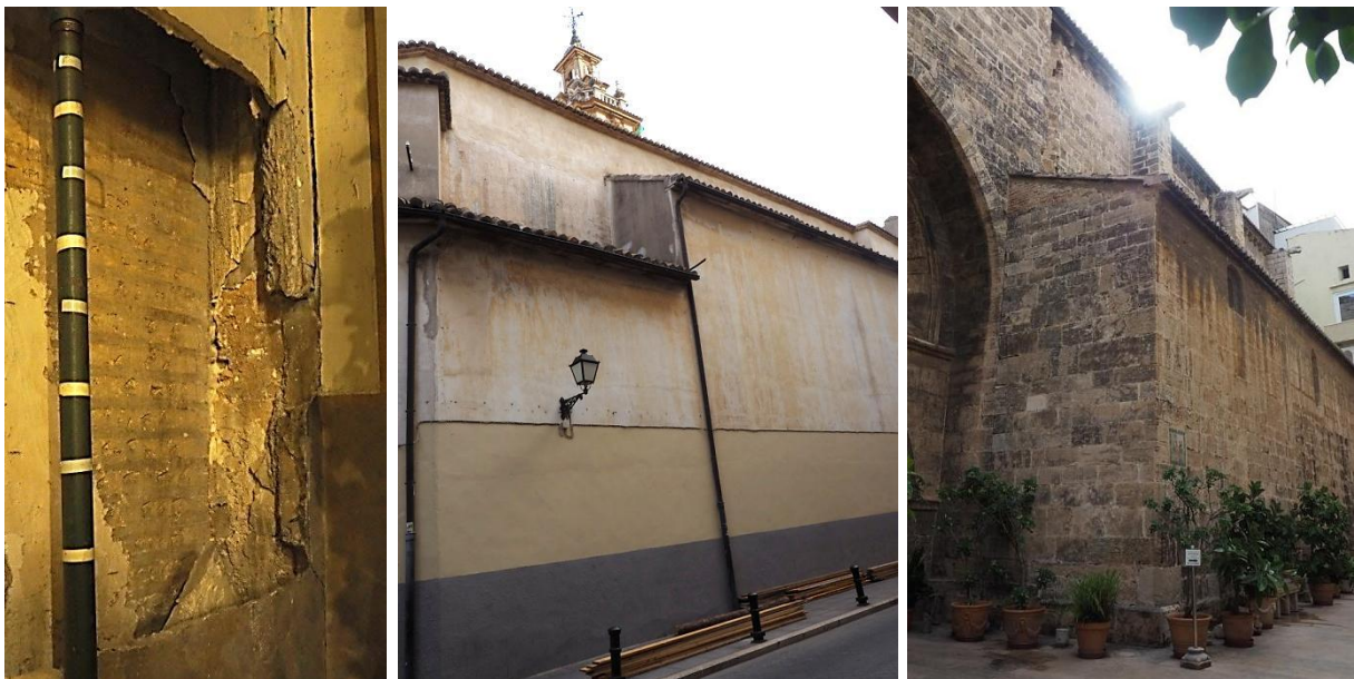
Figura IV.69. Muro transversal pasante, perteneciente a la primera capilla izquierda sita a los pies del altar mayor; la izquierda de la fotografía corresponde a dicho muro construido en el siglo XIV-XV y la derecha al muro de fondo de una nueva capilla ejecutado —con una técnica diversa— para cerrarla al exterior durante la fase 3 en el siglo XVI (izq.). Exterior capillas laterales de la Capilla de la Comuni3n de Algemesi (centro). Exterior capillas laterales de la iglesia de San Juan del Hospital, Valencia (der.).
