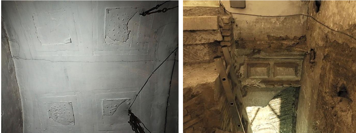
Figura IV.111. Bóveda de cañón con huellas de unos casetones fingidos, sita en el altar de la Mare de Déu de la Salut (izq.). Arranque de dicha bóveda donde resalta el simulado almohadillado clasicista (der.).
