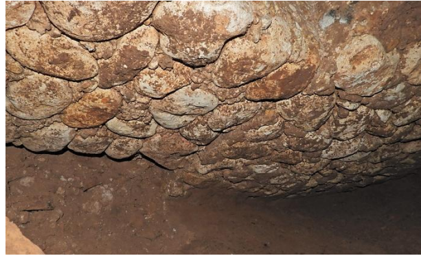
Figura IV.36. Capa de regularización, vista cenital.
