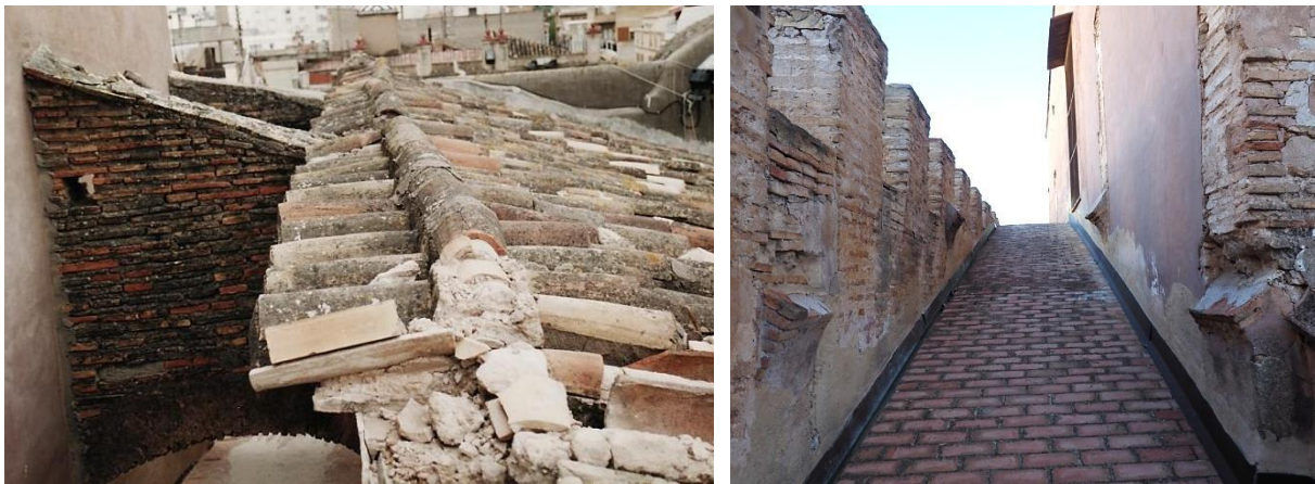
Figura IV.114. Acodalamiento de la antigua cubierta a un agua (izq.). Vestigios del acodalamiento anterior, localizados en la cubierta transitable de la Capilla de la Comunión. (der.).
