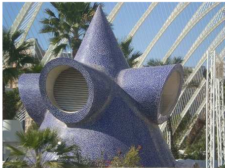
Figura 5. Elemento de ventilación de la Ciudad de las Ciencias y las Artes formado por la intersección de un cono y dos cilindros.
