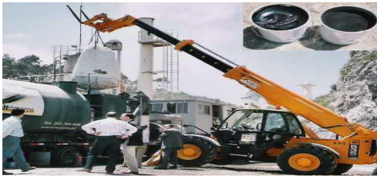
Ilustración 7. Adición del polvo de neumáticos al pavimento. (Fuente: RENEAN) 9 .
