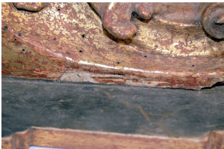
Fig. 21 Patologías encontradas "Intervención previa"
