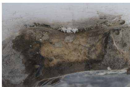
Fig. 14. Ensayo de limpieza con empaco.
