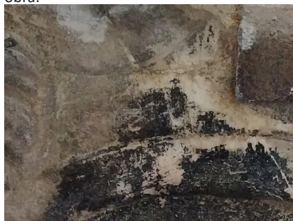
Fig. 9. Pátina ennegrecida en la superficie pétre.
