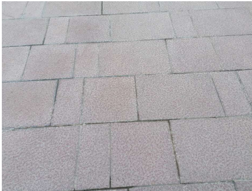
Figura 12. Modelo camino principal de losas de hormigón.
