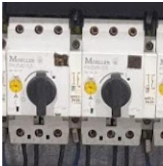
Fig. 17 Guardamotores de la máquina junto con las cámaras auxiliares que dan la señal
