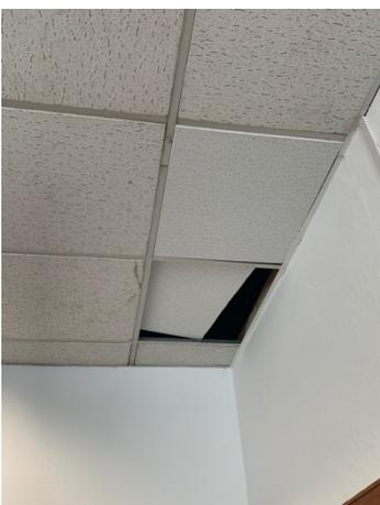
Fig. 22. Gotera presente en el almacén de la planta primera.
