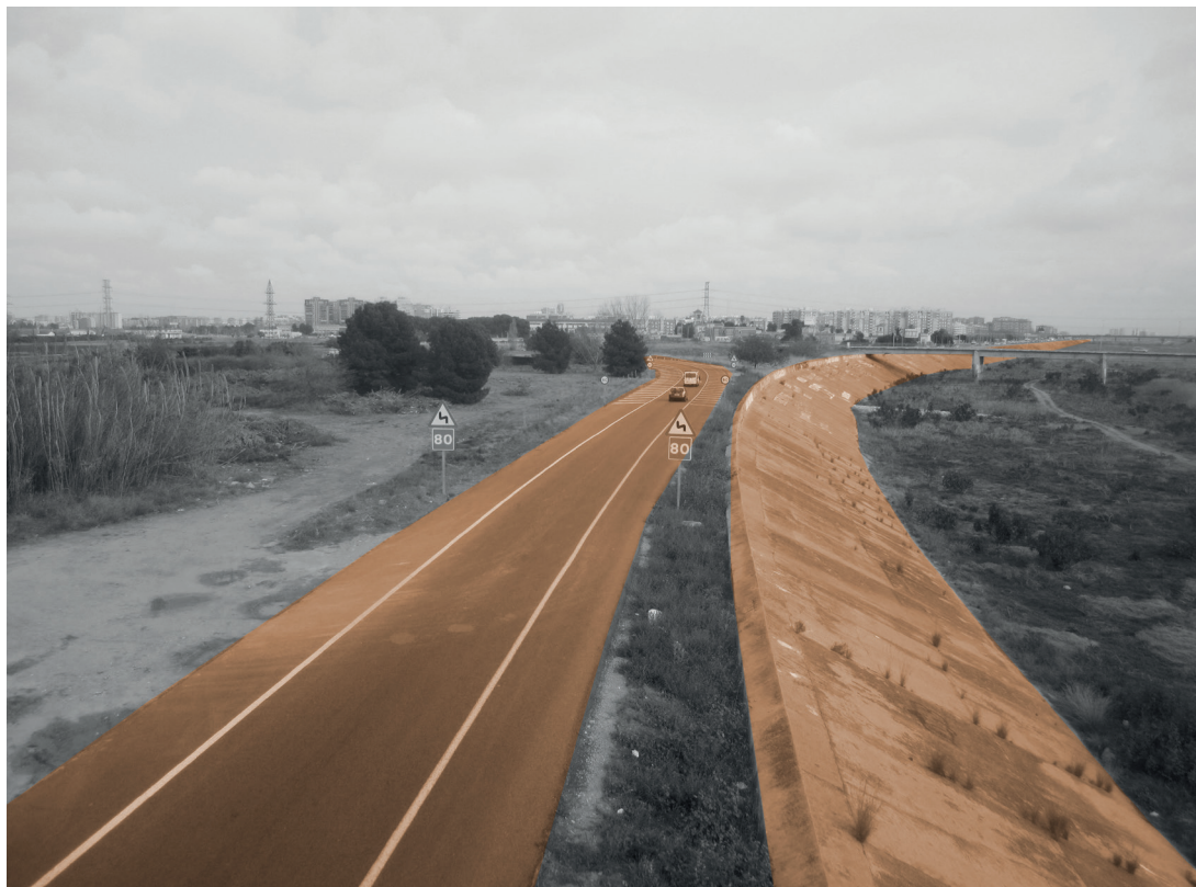
Imagen del talud y la carretera norte del nuevo cauce
