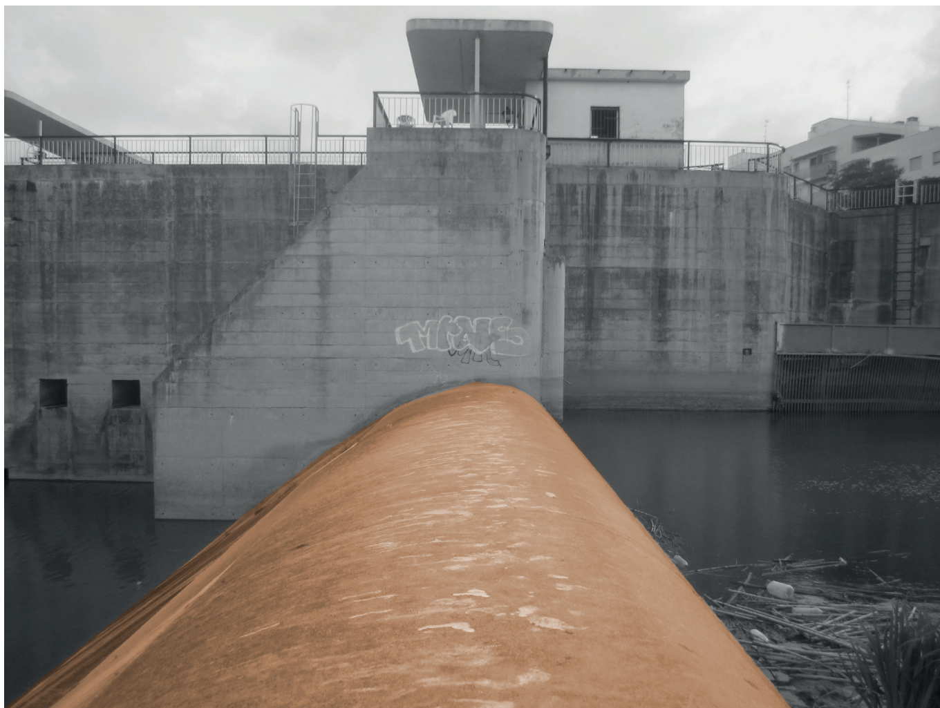
Azud previo al desvío del cauce hacia el nuevo recorrido, junto al núcleo de Quart de Poblet.
