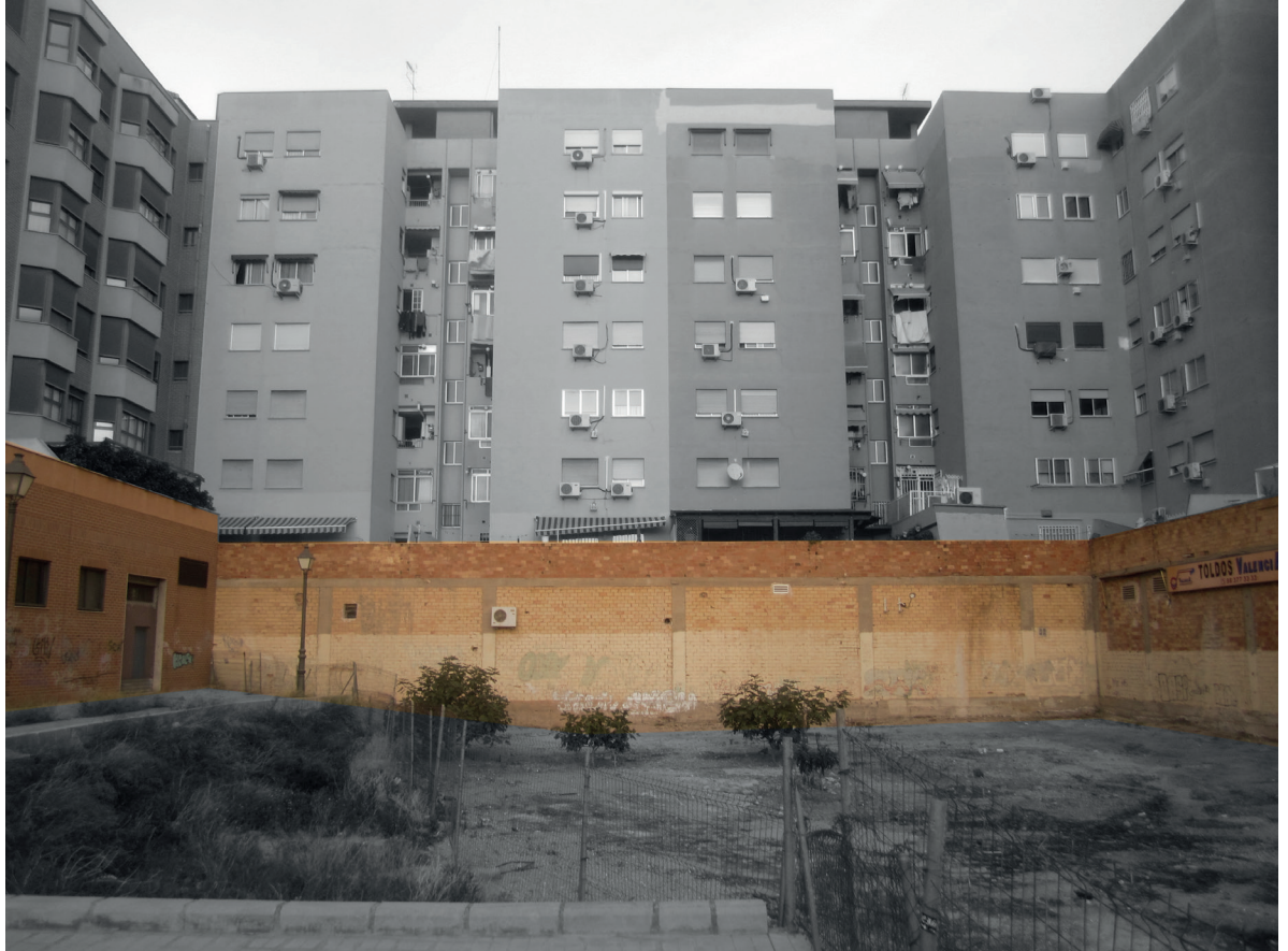
Espacio interior de manzana abierto, resultante de la paralización de la construcción. Deterioro del espacio público.
