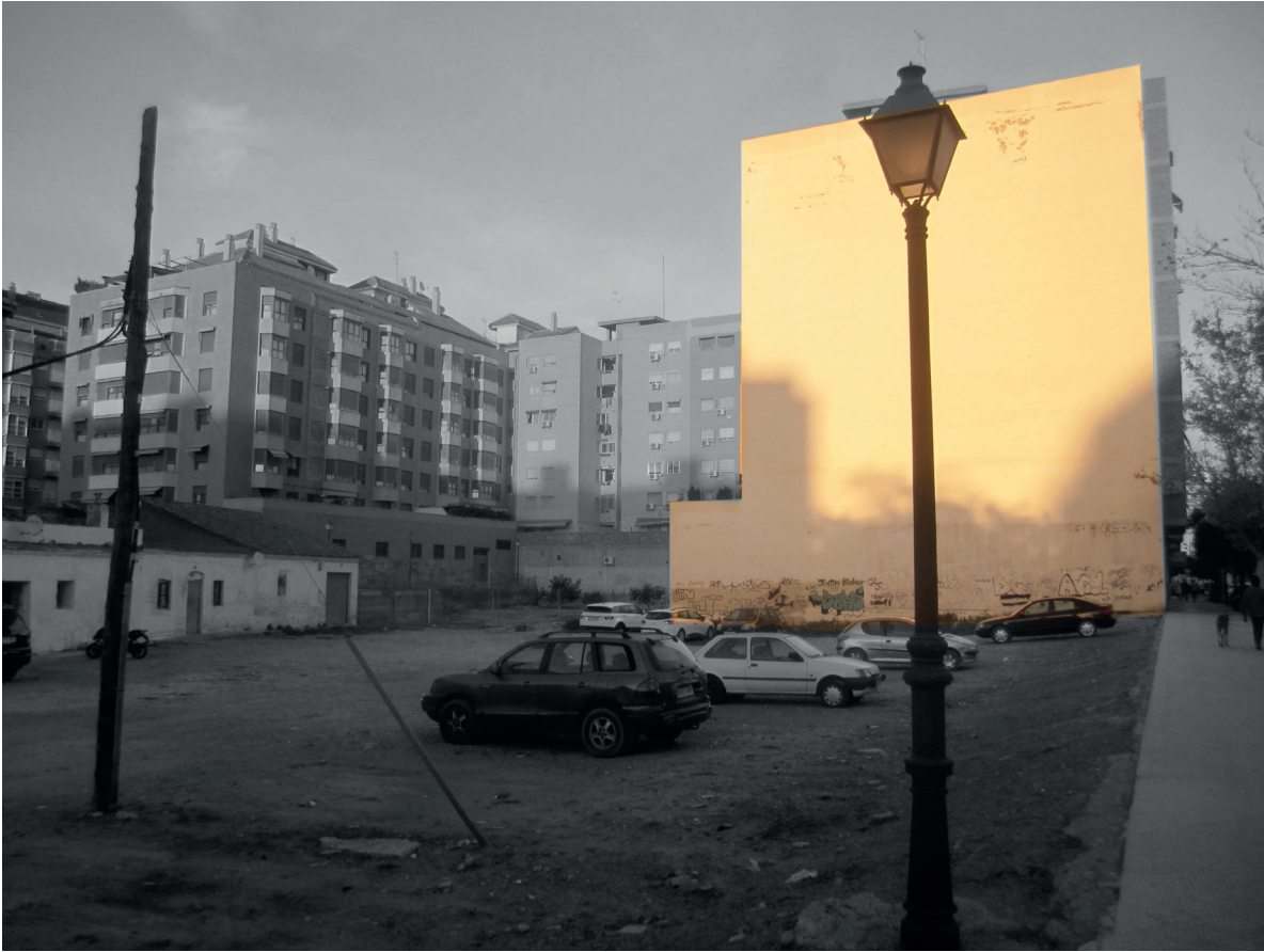
Medianera resultante de la manzana junto a la alquería de los Frailes. La construcción quedó frenada por el estado de protección del la alquería.
