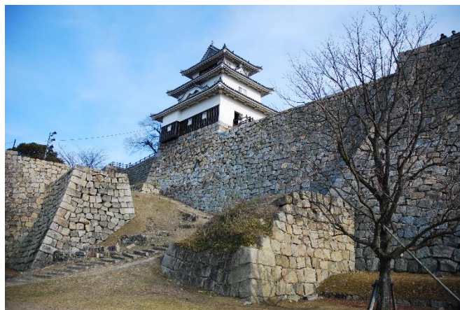
Ilustración 1 boca de tigre en el ascenso al honmaru, castillo de Marugame (Kagawa) (fotografía: Sergio Almenar)
