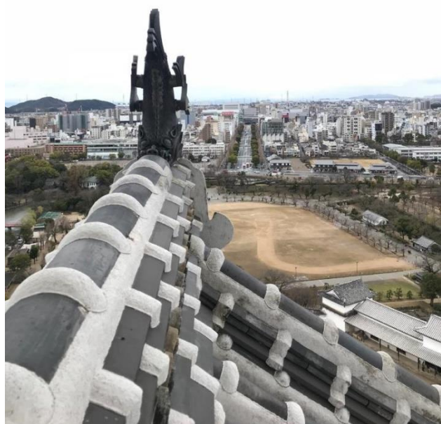
Ilustración 31 Juntas de mortero blanco después de la reparación (fotografía: Sergio Almenar)
