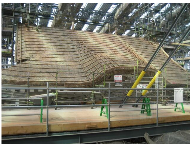
Ilustración 11 Último piso del tenshu, con la cubierta desprovista de tejas (fotografía: Terumasa. https://commons.wikimedia.org/wiki/File:Himejicastle-restoration-roof2011.jpg , usado bajo licencia Creative Commons Attribution-Share Alike 3.0 Unported)
