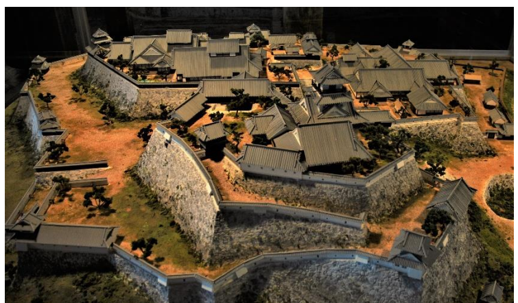
Ilustración 9 maqueta del castillo de Kochi, de estilo renkaku. Honmaru en primer plano. El Ni-no-maru y el san-no-maru no comparten prácticamente ningún vértice con el honmaru, dejándolo expuesto (fotografía: Sergio Almenar)
