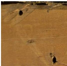
**Figura 55.** Fotografía detalle de daños mecánicos por los clavos.
