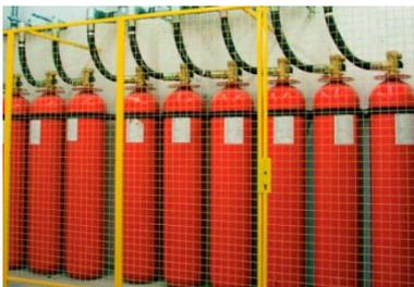
Figura 98. Sistema de inertización de depósitos.
