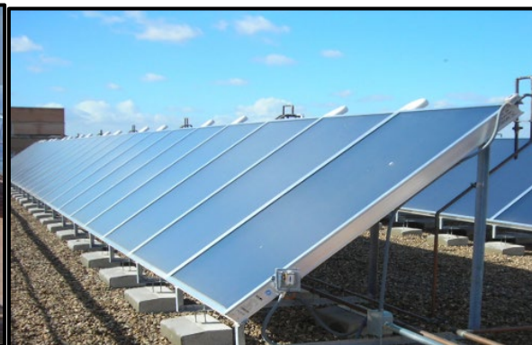
Figura 6. Captador solar sin concentración (Fuente: Caloryfrio.com)
