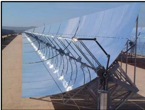
Figura 5. Captador solar con concentración (Fuente: Energíasolar.lat)
