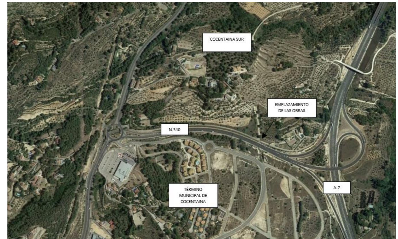
Imagen 2. Emplazamiento de las obras.
