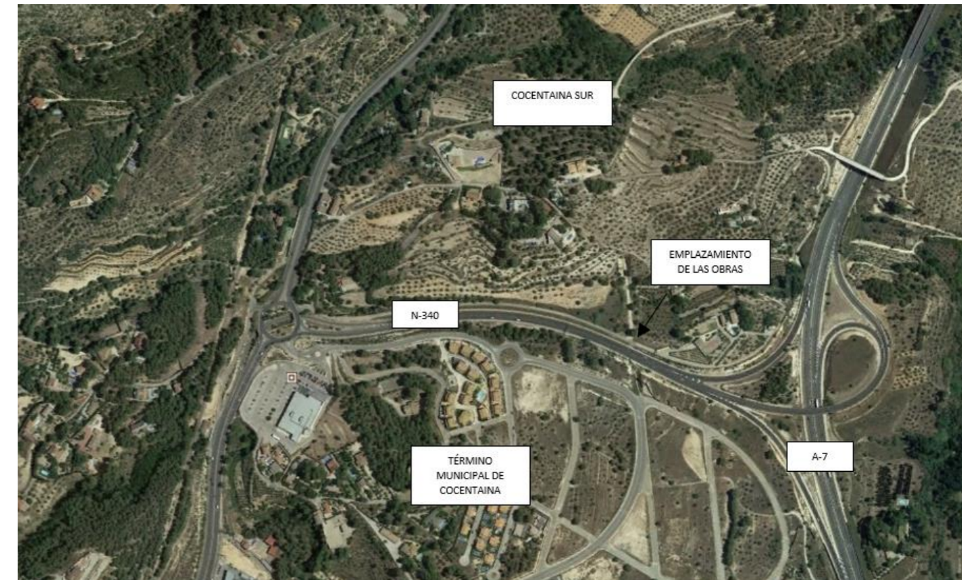
Imagen 5. Emplazamiento de las obras.
