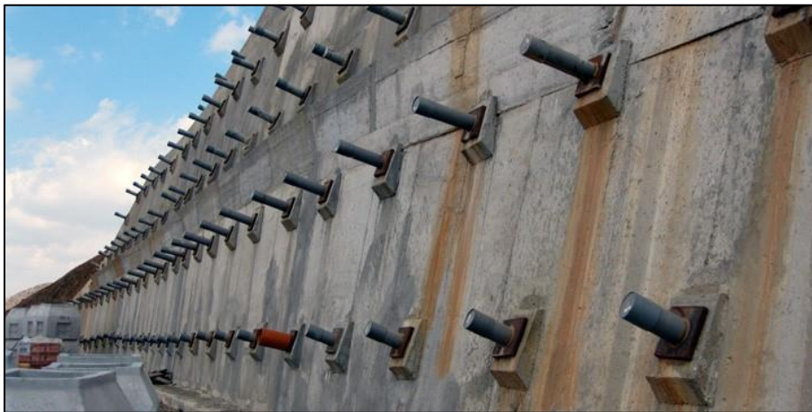
Figura 1. Anclajes permanentes al terreno. Fuente: https://victoryepes.blogs.upv.es/tag/anclaje/
