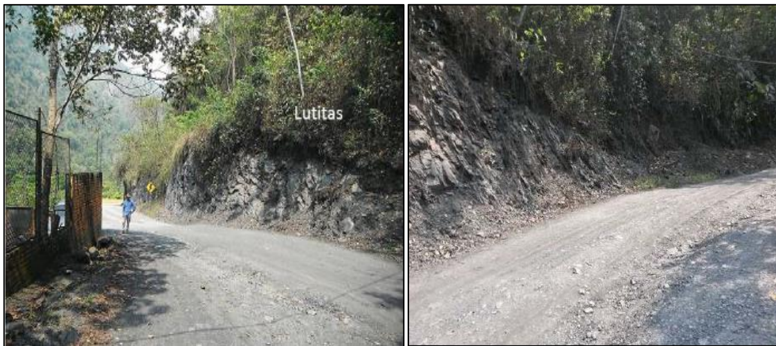
Figura 3. Sectores con taludes compuestos por lutita
