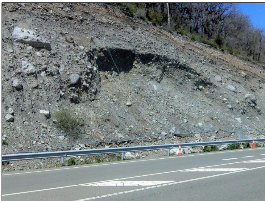
Figura 2. Colocación de malla triple torsión anclada. Fuente: Propia http://geotecnia.info/index.php/taludes-malla-quiado-triple-torsion/
