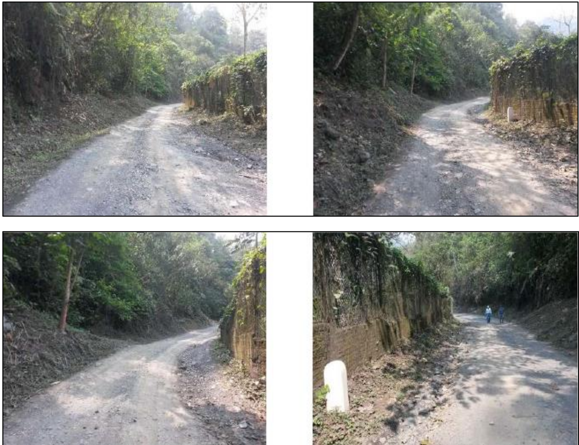
Figura 5. Zona central de la vía
