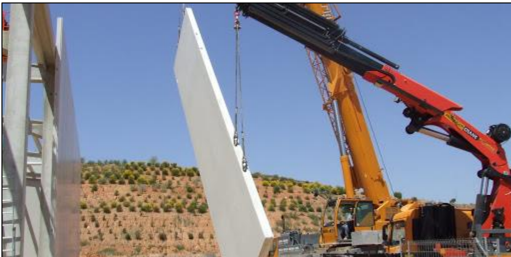
Figura 3. Montaje de paneles prefabricados con grúa autopropulsada. Fuente: http://prefabricadoseguro.com/
