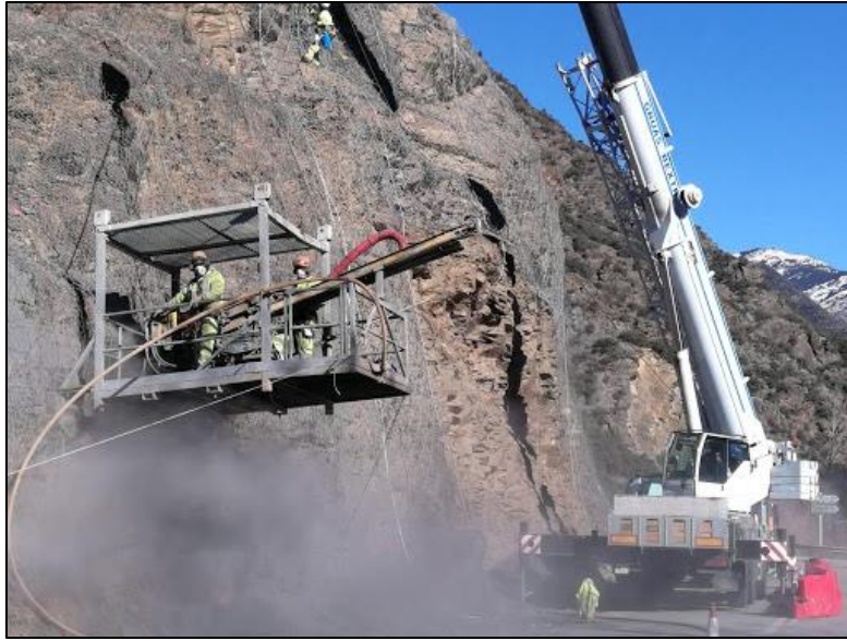
Figura 4. Perforación en roca mediante maquinaria de perforación. Fuente: http://www.inaces.com/
