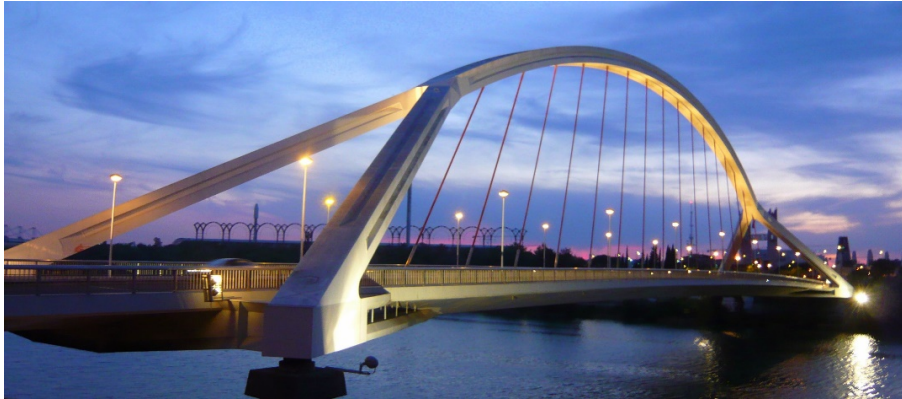
Figura 6. Puente de la Barqueta (Sevilla). (Fuente: Google imágenes b, 2015).
