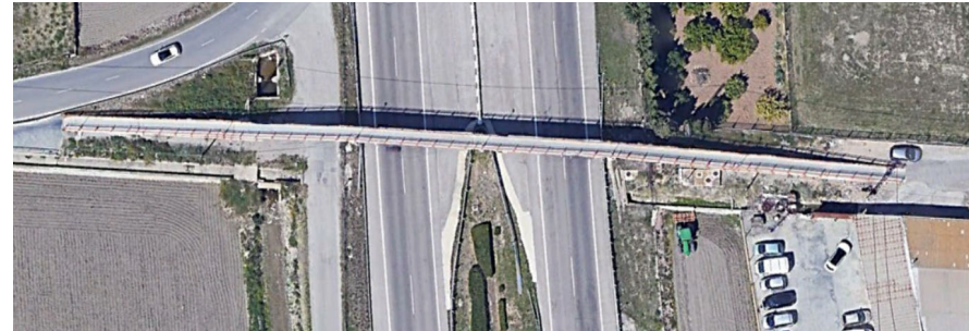
Figura 3. Ubicación de la pasarela actual. (Fuente: Google Earth).
