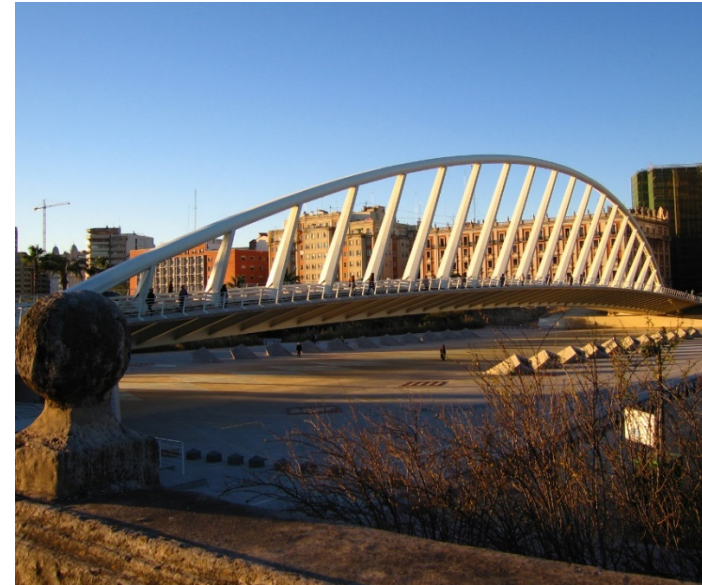
Figura 5. Puente de la Alameda (Valencia). (Fuente: Google imágenes a, 2020).
