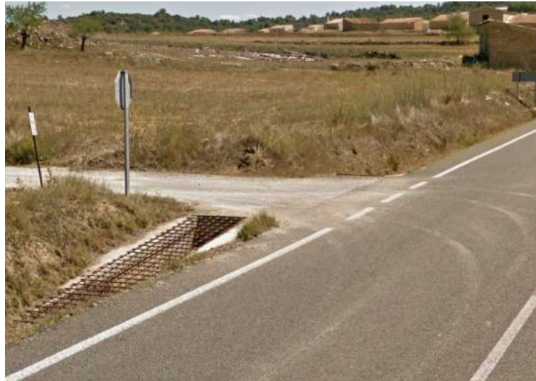
Figura 47: Ejemplo de salvacunetas protegido con rejilla metálica. Fuente: Google Earth
