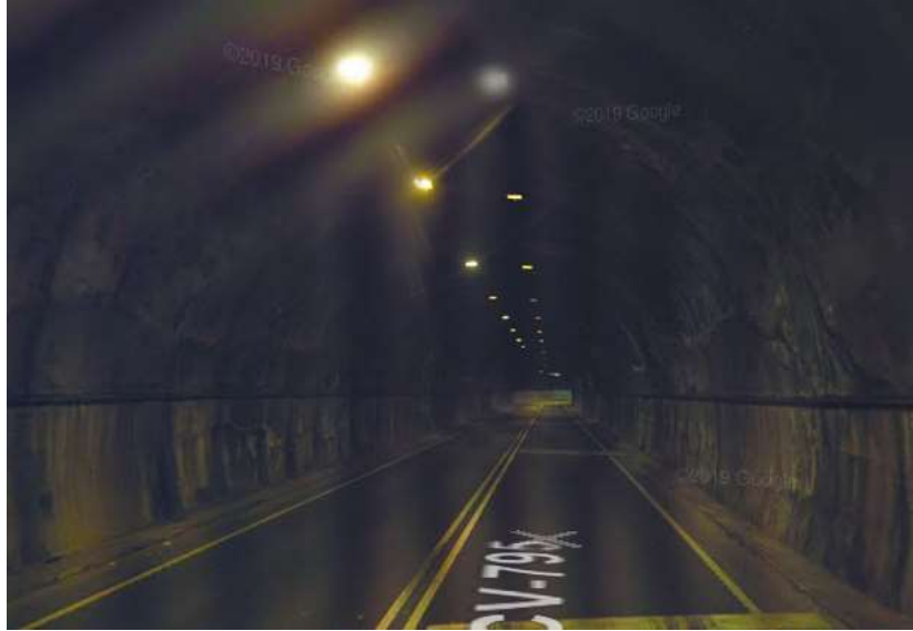
Figura 24: Vista del interior del Túnel del Salt. Fuente: Google Earth.
