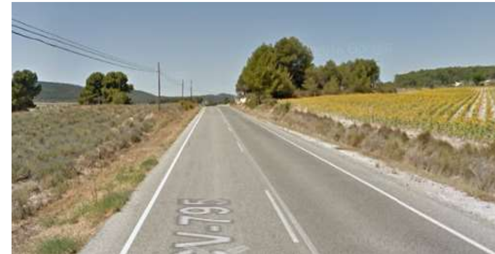
Figura 30: Cambio de rasante en el sentido ida. Fuente: Google Earth
