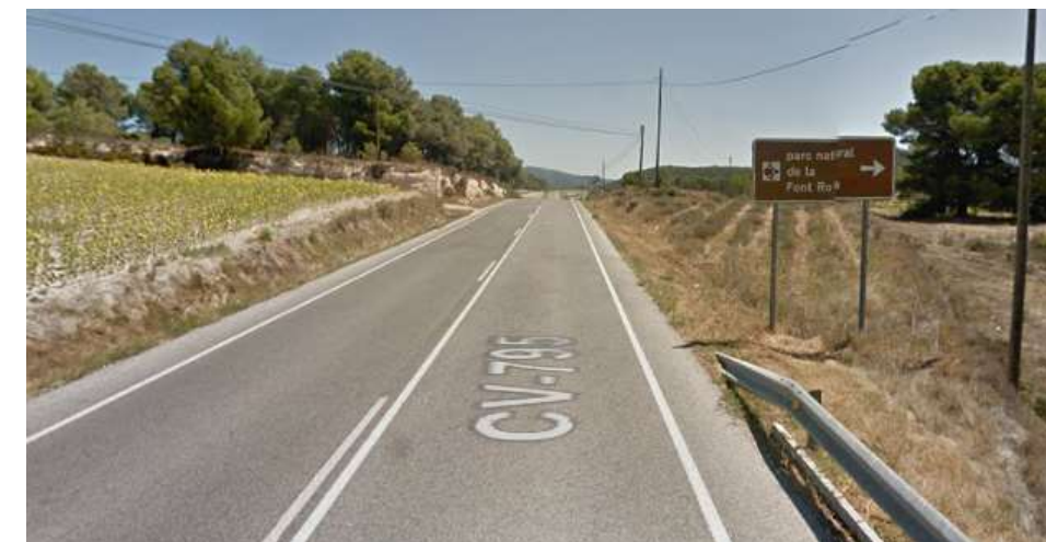
Figura 31: Cambio de rasante en el sentido vuelta. Fuente: Google Earth
