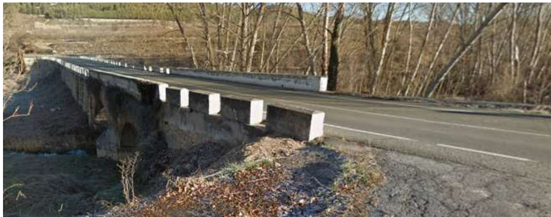
Figura 25: Puente sobre el Vinalopó.
