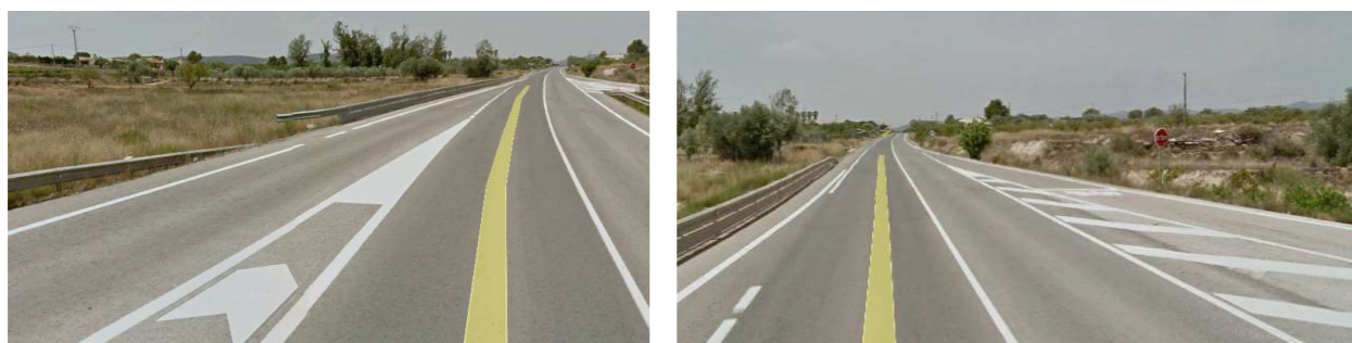
Figura 40. Acceso 50 y 51. (Fuente: Google Earth)
