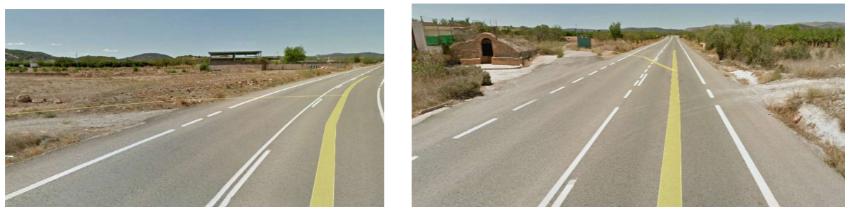
Figura 19. Acceso 1,2 y 3. (Fuente: Google Earth)
