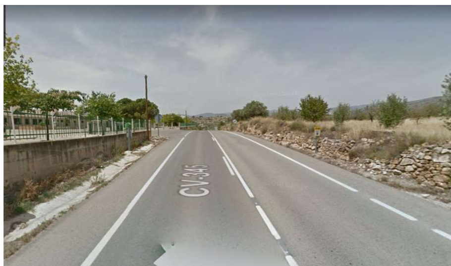
Figura 49. Punto P.K. 9+000 con falta de visibilidad. (Fuente: Google Maps)
