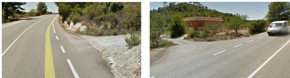
Figura 33. Acceso 35 y 36. (Fuente: Google Earth)
