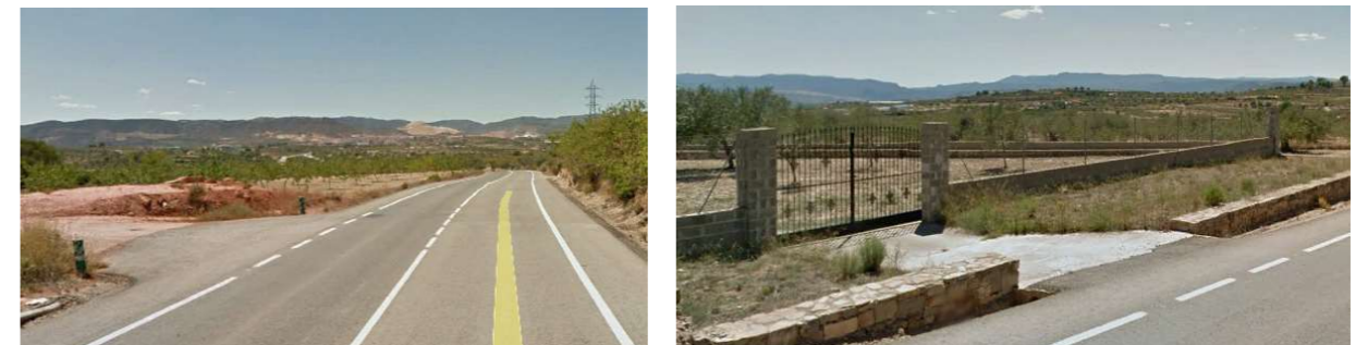
Figura 38. Acceso 46 y 47. (Fuente: Google Earth)
