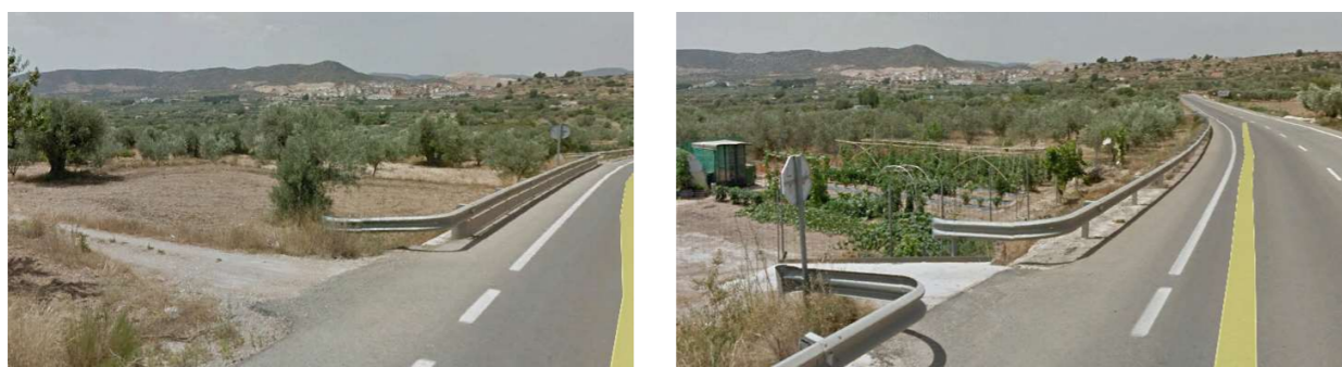
Figura 43. Acceso 56 y 57. (Fuente: Google Earth)
