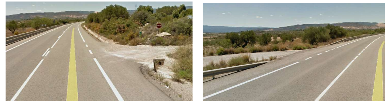
Figura 36. Acceso 42 y 43. (Fuente: Google Earth)
