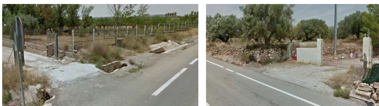
Figura 41. Acceso 52 y 53. (Fuente: Google Earth)
