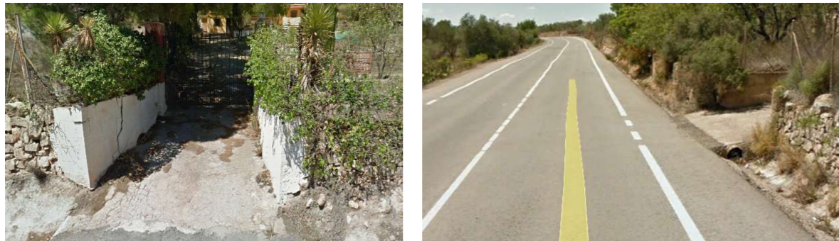
Figura 34. Acceso 37 y 38. (Fuente: Google Earth)
