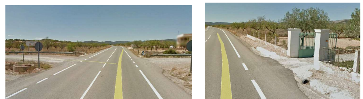
Figura 23. Acceso 12, 13 y 14. (Fuente: Google Earth)
