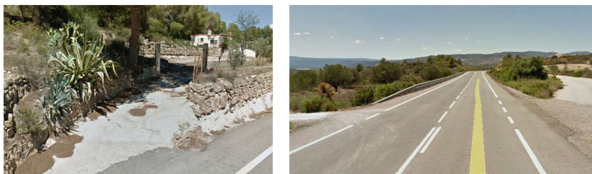
Figura 35. Acceso 39, 40 y 41. (Fuente: Google Earth)
