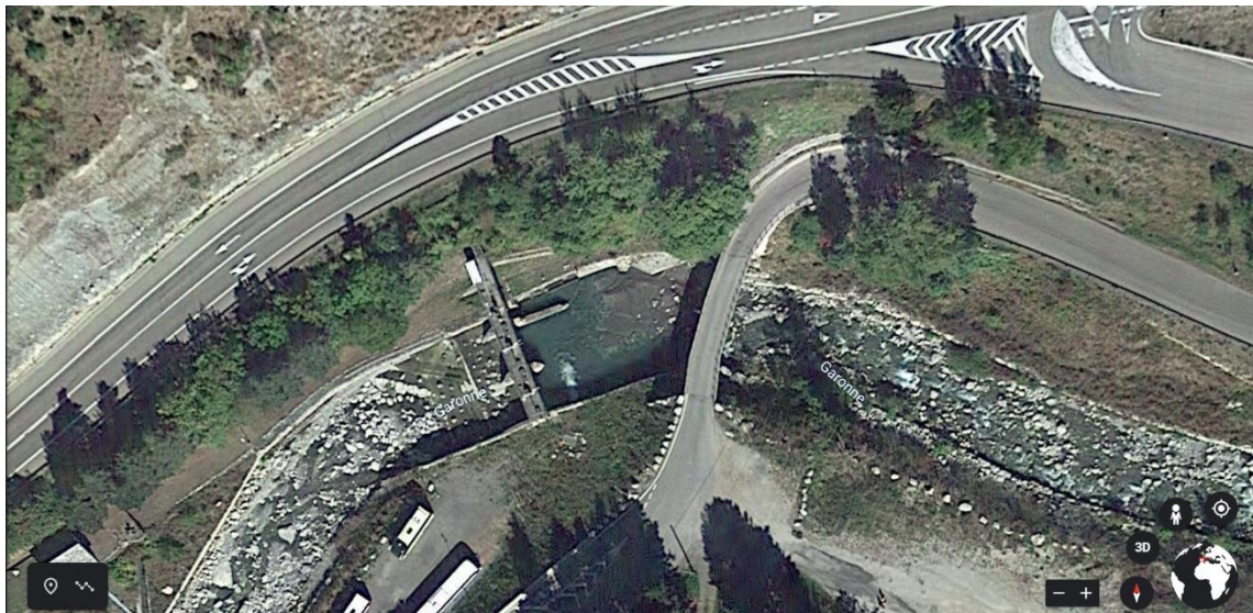
Figura 59. Ortofoto del puente municipal y la presa sobre el río Garona al comienzo de la zona de estudio
