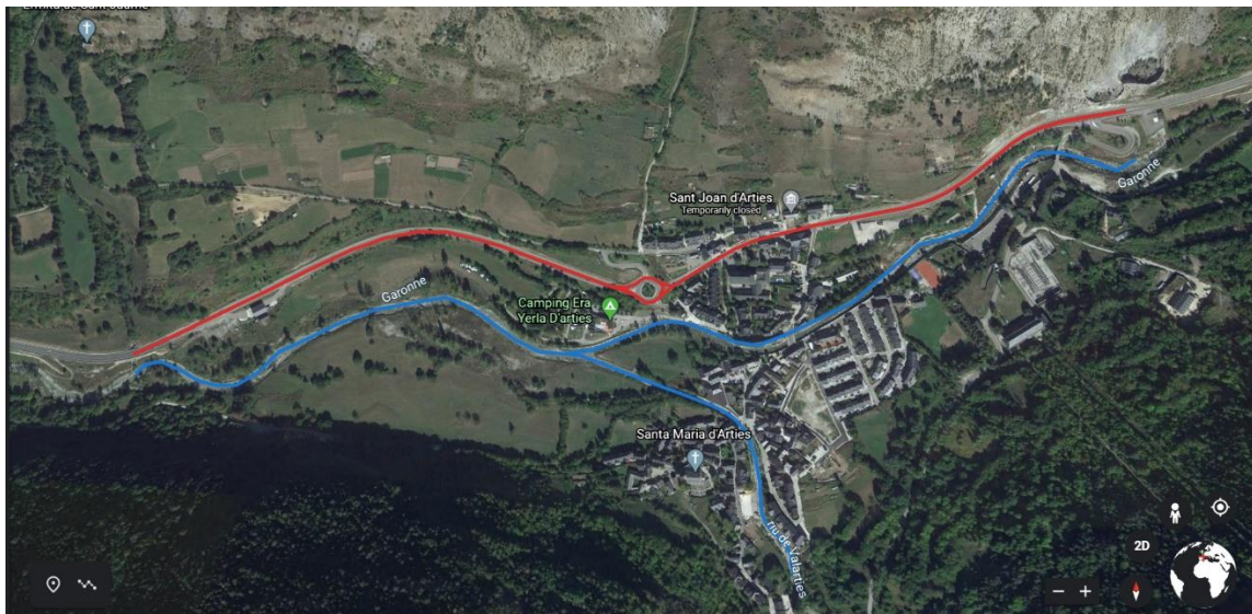
Figura 76. Carretera C-28, que discurre de manera paralela al cauce del río Garona (2).
