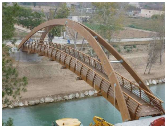
Figura 5. Pasarela peatonal de madera tipo arco atirantada con tablero inferior tipo "Bowstring", similar a la propuesta para uno de los tramos de la pasarela del presente proyecto básico. Fuente: www.mediamadera.com
