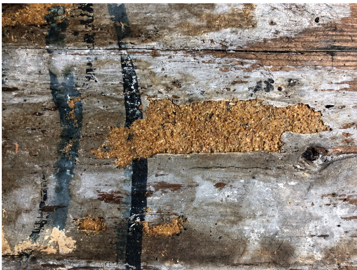
Fig. Anexo 31. Reintegraciones volumétricas del soporte de madera con serrín y PVA.
