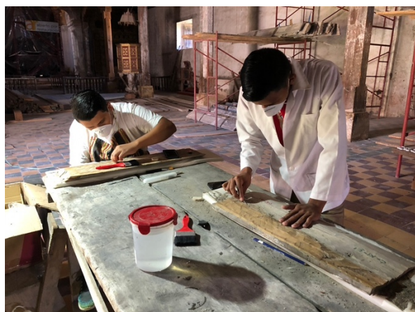
Fig. 28. Alumnos voluntarios de la carrera de arquitectura de la Universidad Autónoma de Honduras realizando la limpieza en seco del reverso de las tablas.
