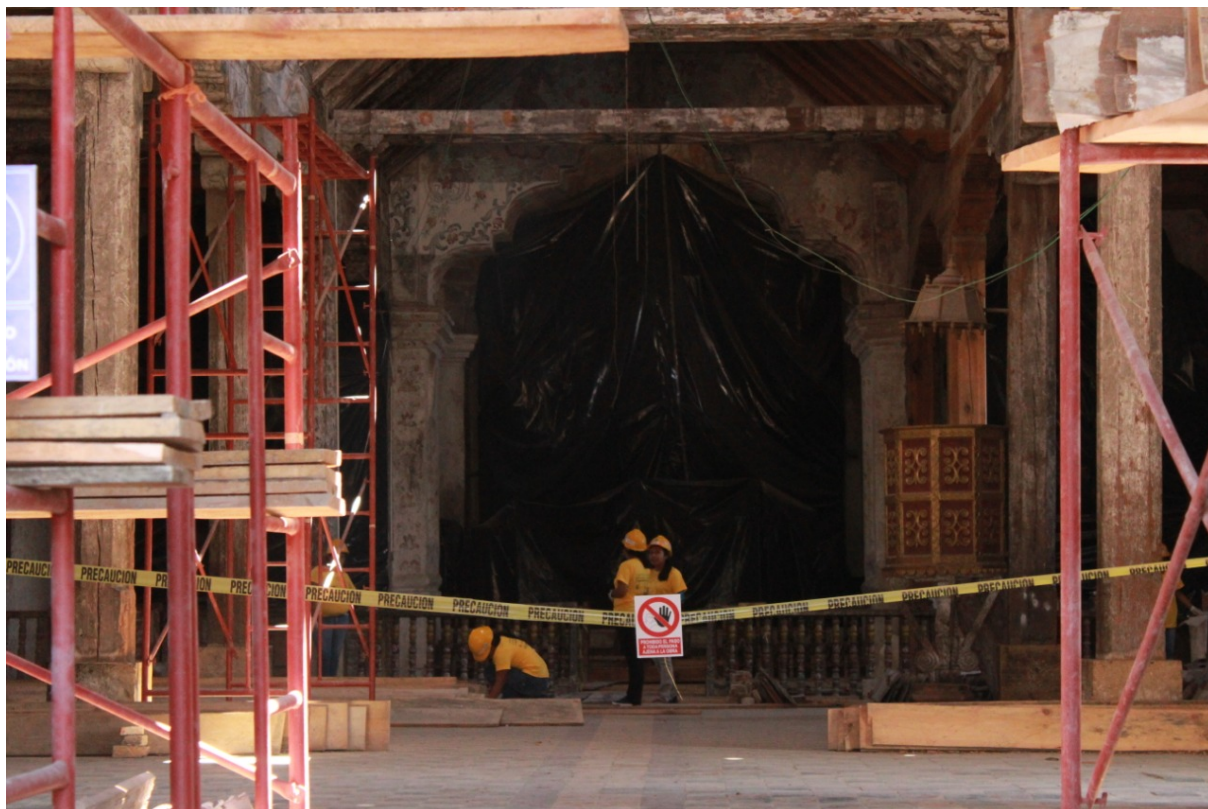
Fig. Anexo 12. Primeros trabajos de restauración en la iglesia. Interior cerrado por obras.
