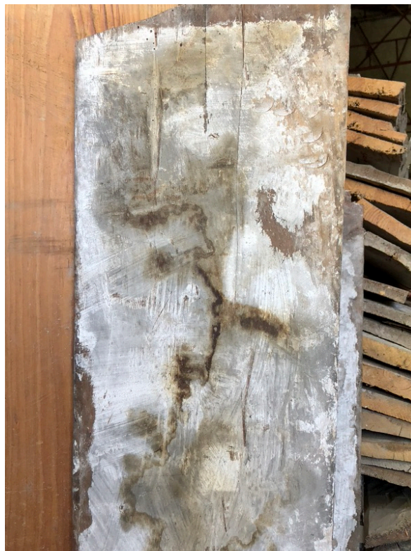
Fig. 20. Manchas oscuras sobre la policromía del entablado debido a las humedades.
