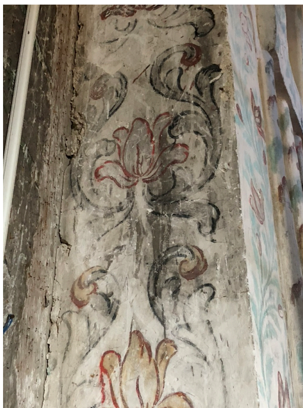
Fig. 12. Manchas oscuras de humedades sobre la policromía de los elementos de madera.
