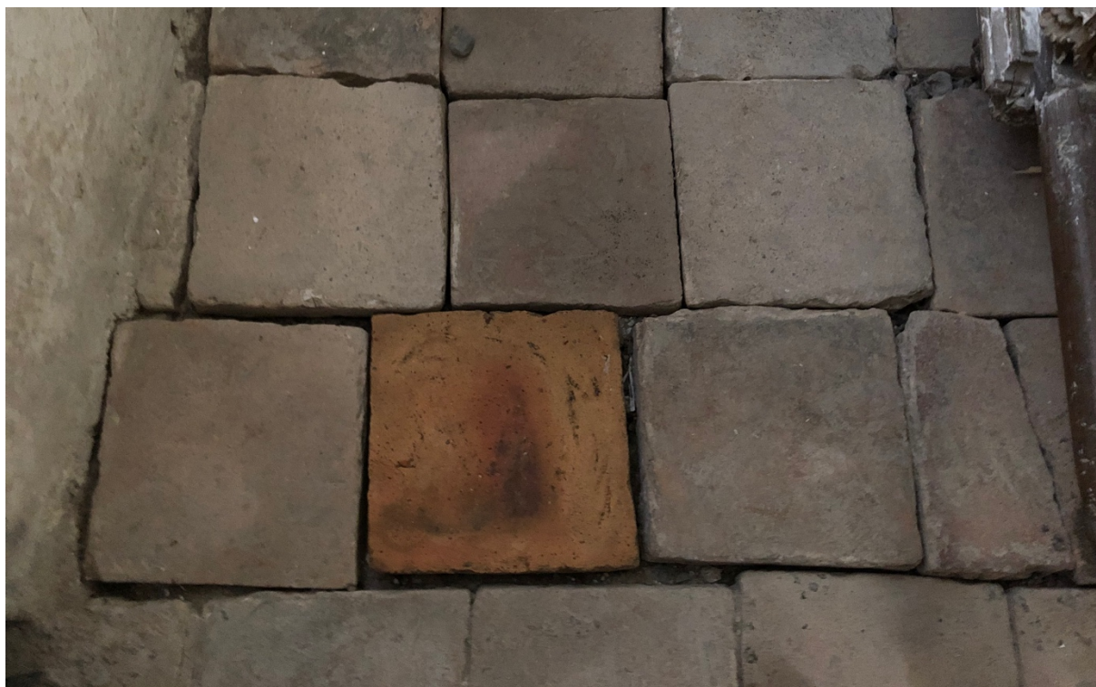
Fig. Anexo 23. Resultados de la limpieza de losetas de barro de las capillas laterales de la iglesia.
