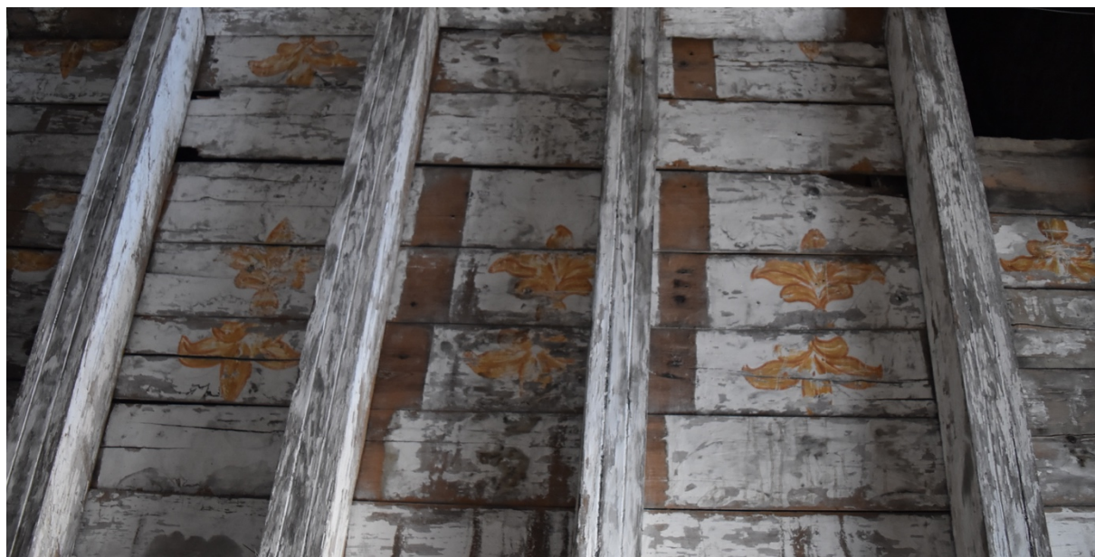
Fig. 21. Falta de policromía ocasionada por la incorrecta colocación de las tablas tras su desmontaje.
