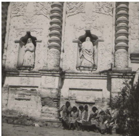
Fig. Anexo 1. "Cuadernos de Arquitectura Virreina". Fachada principal del inmueble.
