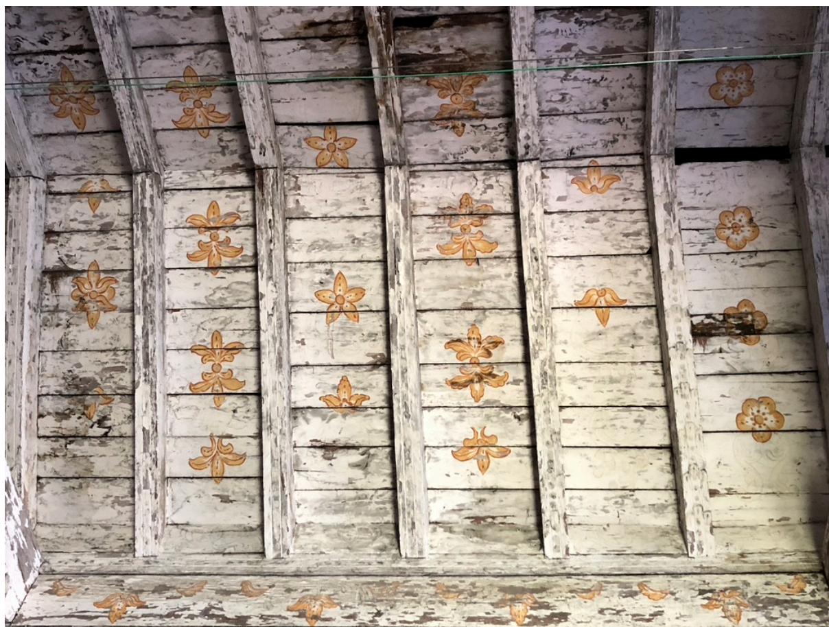
Fig. 15. Decoraciones de flores de Lis sobre el entablado del techo de la nave central.
