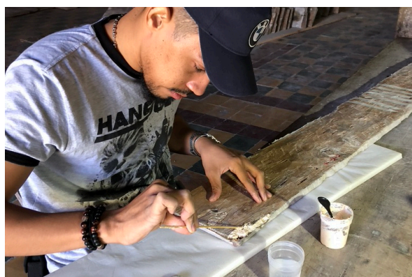
Fig. 31. Alumno voluntario de la carrera de arquitectura de la Universidad Autónoma de Honduras llevando a cabo la reintegración volumétrica del soporte de madera.
