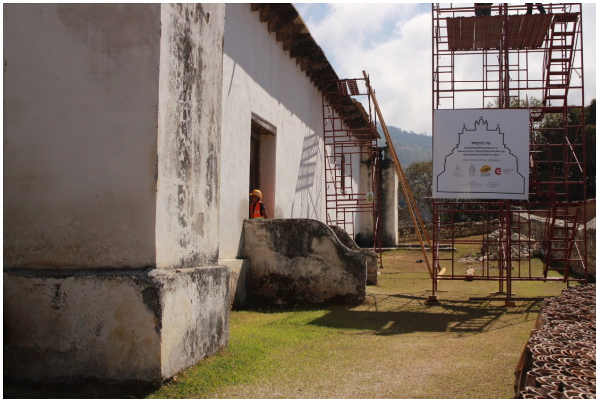
Fig. Anexo 11. Primeras labores de restauración en la Iglesia. Restauración de estructuras y techo.
