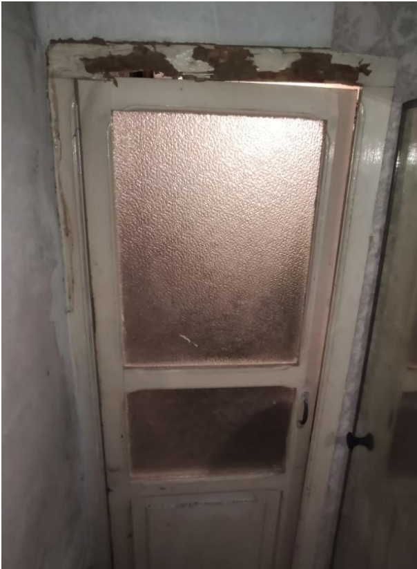
Imagen 18. Carpintería interior. Fuente: Autor
