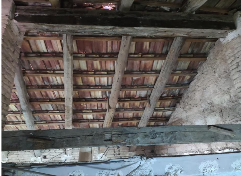
Imagen 8. Cubierta. Fuente: Autor.
