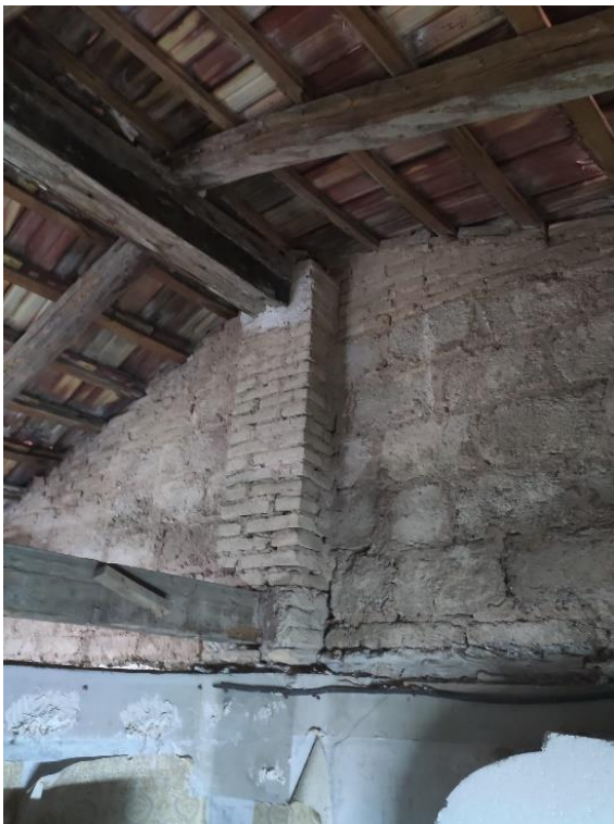
Imagen 7. Encuentro medianera con cubierta.
