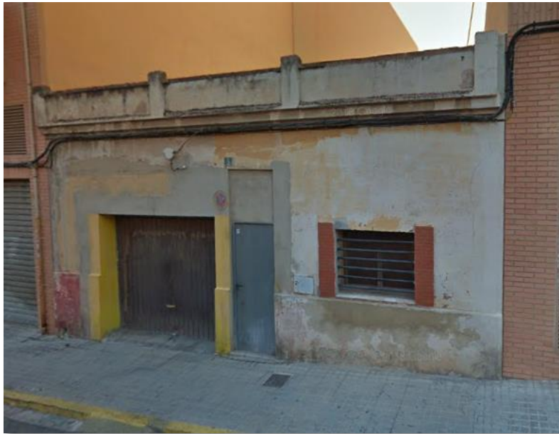
Imagen 2. Estado actual inmueble. Fuente: Autor
