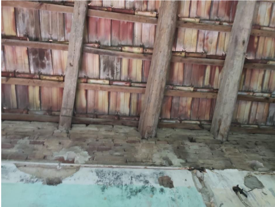
Imagen 16. Cubierta. Fuente: Autor
