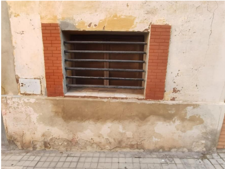
Imagen 10. Carpintería Exterior. Fuente: Autor
