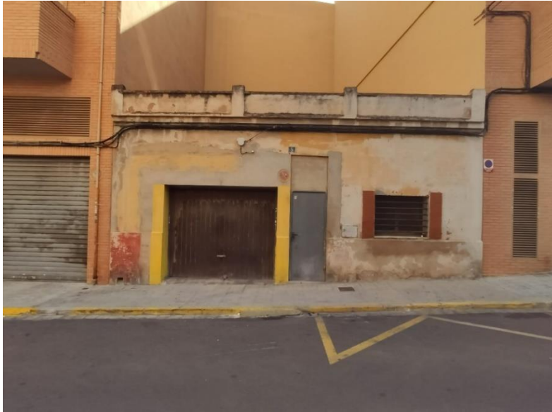
Imagen 3. Estado actual inmueble. Fuente: Autor
