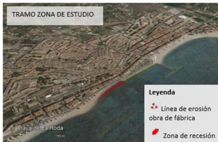
Ilustración 12. Zona de erosión, recesión de la línea de costa. Fuente: Propia
