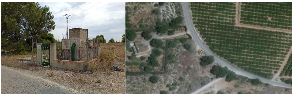
Figura 17. Captura en campo impulsión. Fuente: Elaboración propia
