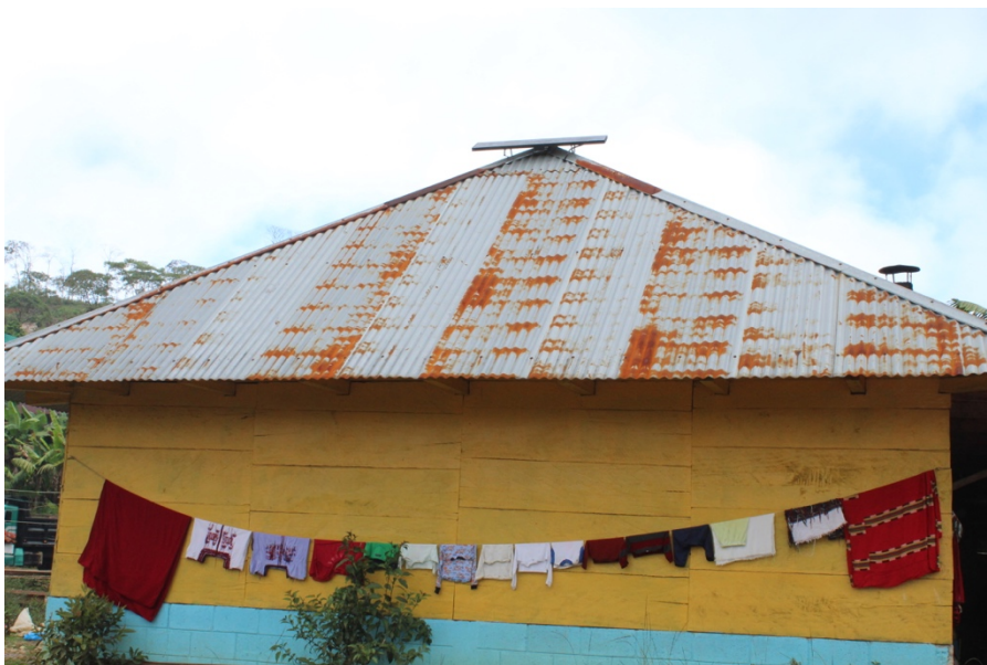
Figura 49 - Viviendas con placas fotovoltaicas.
