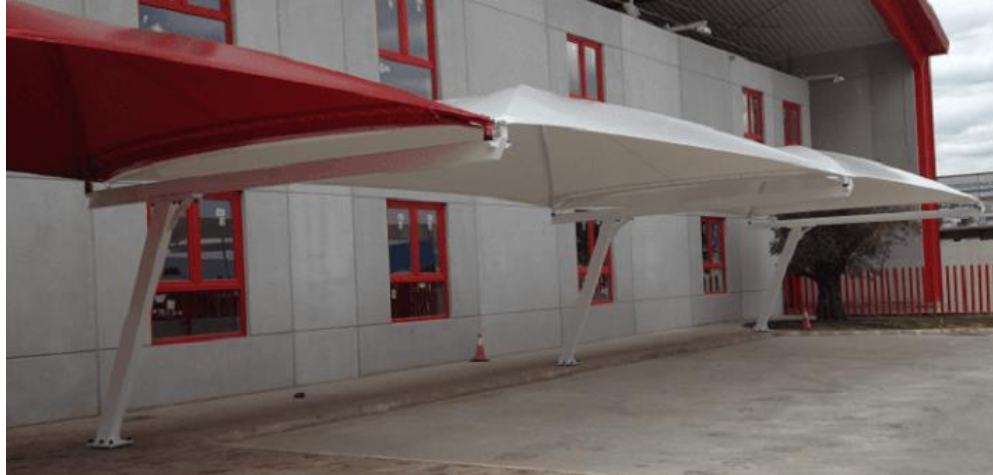
Figura 6: marquesina tèxtil de perfil de tub quadrat lacada.
