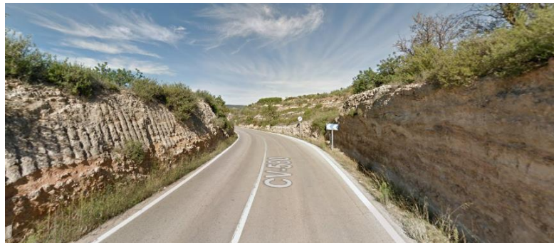
Ilustración 5. Taludes situados en el P.K. 14+050 de la CV.580. (Fuente: Google)
