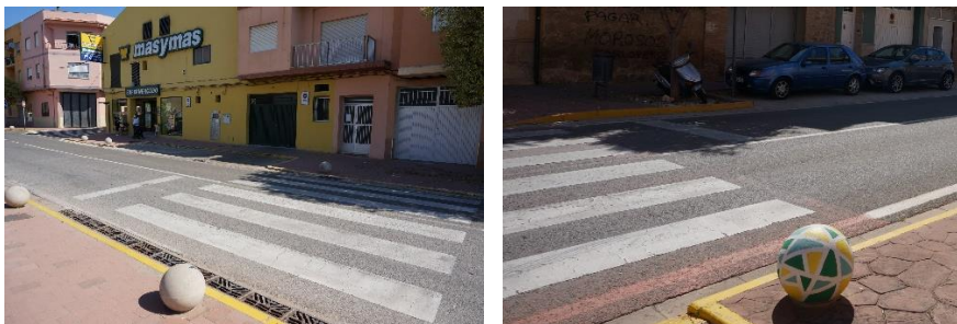
Figura 29. Situación actual de las marcas viales transversales. (Fuente: propia)
