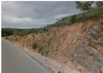
Ilustración 10. Talud situado en el margen derecho de uno de los caminos situado al Este de Navarrés accediendo desde la Calle Eras del Alto. (Fuente: Google)
