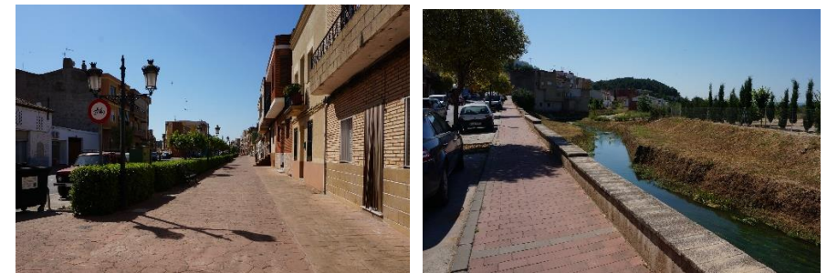
Figura 27. Situación actual de las aceras del municipio de Navarrés. (Fuente: propia)
