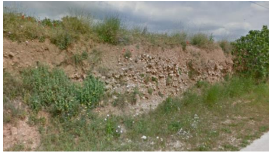
Ilustración 7. Talud situado en los caminos del Oeste del Municipio. (Fuente: Google)
