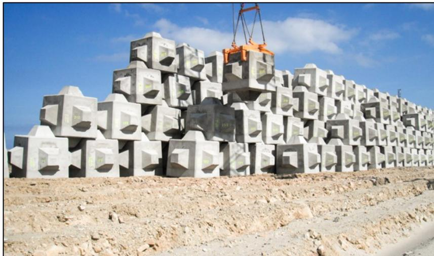
**Figura 7.22.** Acopio de Cubípodos. Fuente: Manual de Cubípodo, 2015
