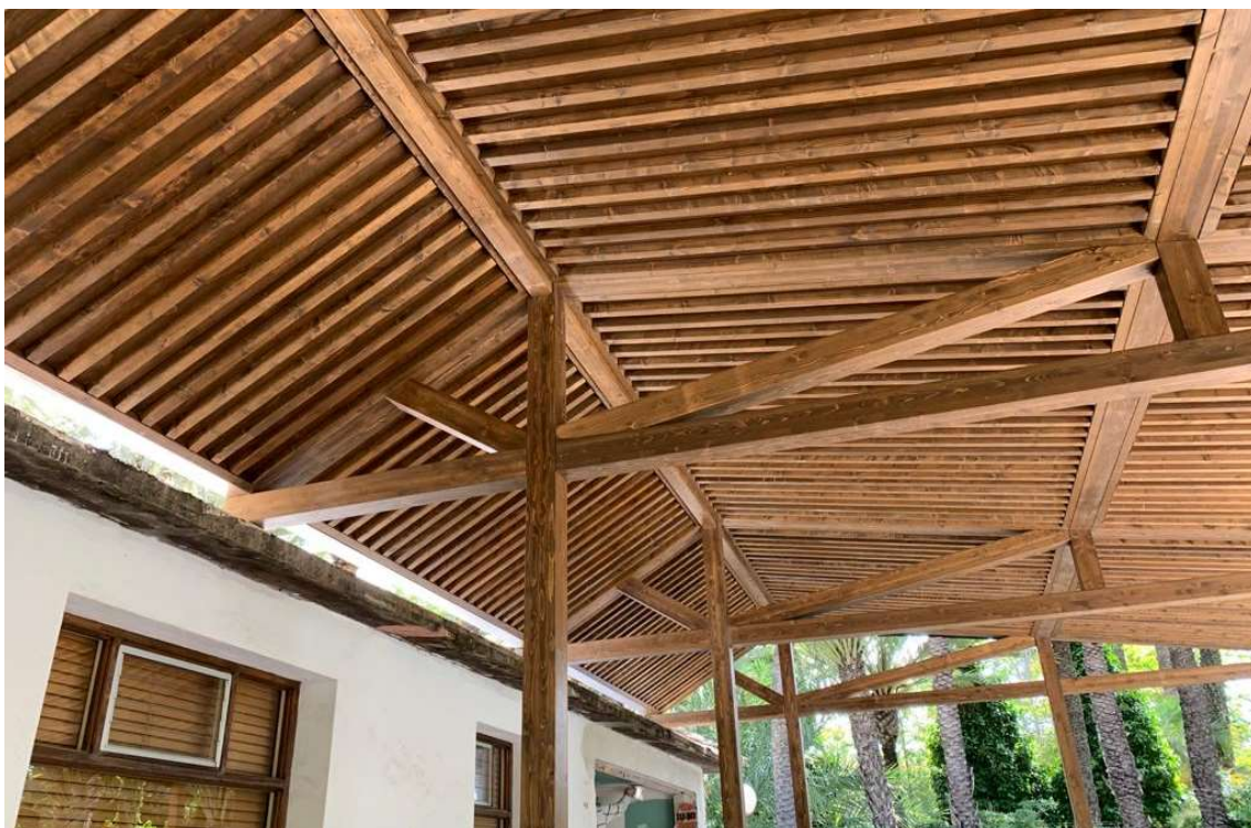
Il·lustració 101: Secuencia de montaje. Cubierta terminada. Imagen de obra.
