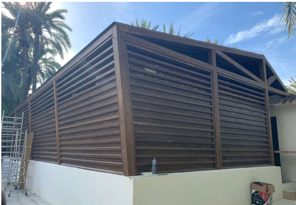
Ilustración 107: Secuencia de montaje. Módulos de pared terminados. Imagen de obra.
