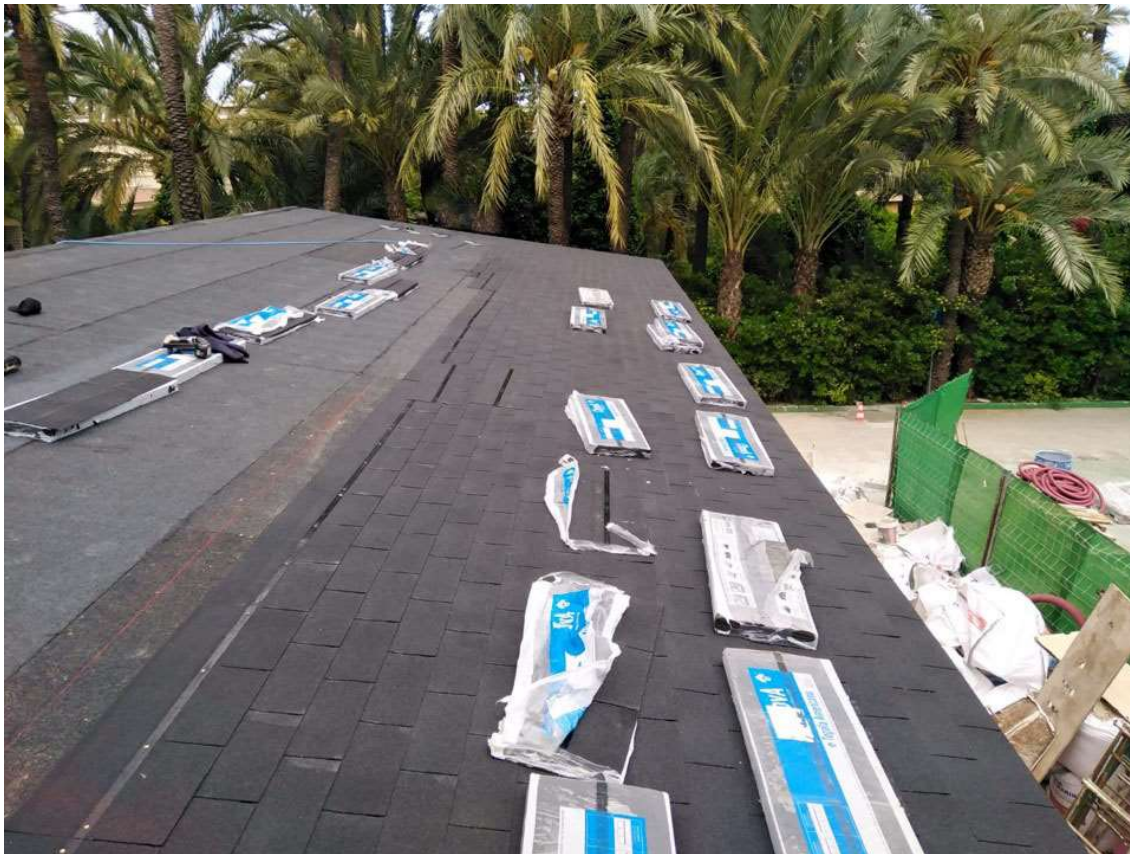
Il·lustració 105: Secuencia de montaje. En proceso de colocación de tégola americana. Imagen de obra.
