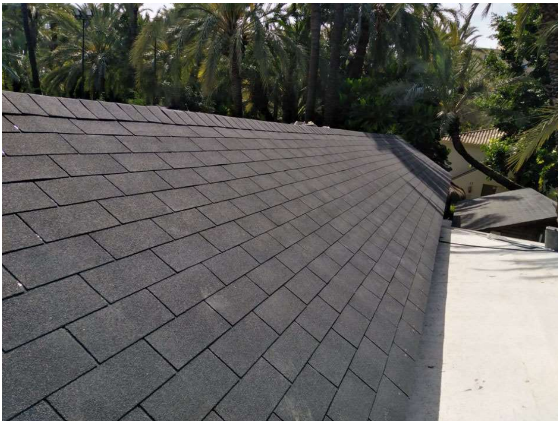
Il·lustració 104: Secuencia de montaje. Tégola finalizada. Imagen de obra.
