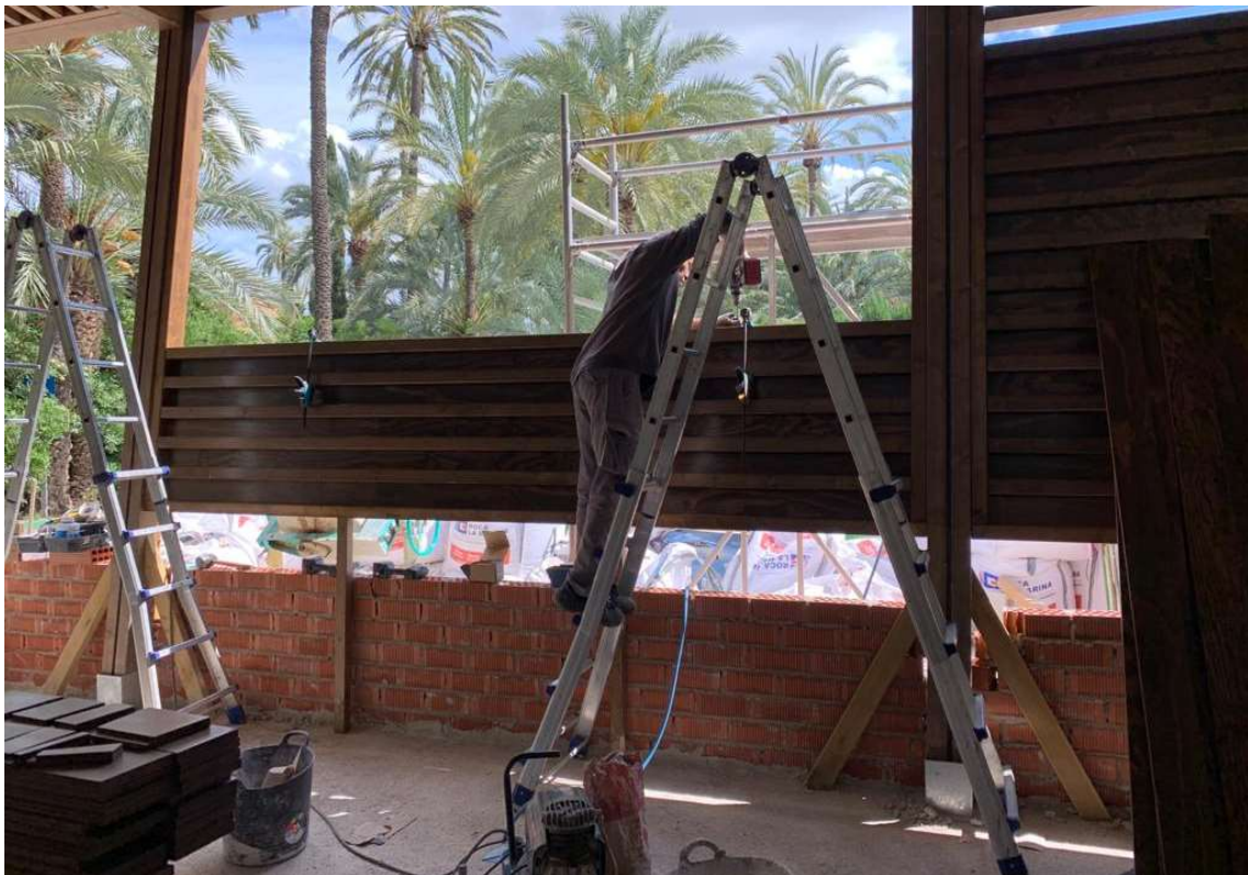
Ilustración 106: Secuencia de montaje. Proceso de montaje de módulos de pared. Imagen de obra.
