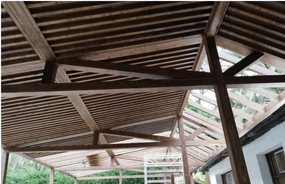
Il·lustració 100: Secuencia de montaje. En proceso de montaje de módulos de cubierta. Imagen de obra.
