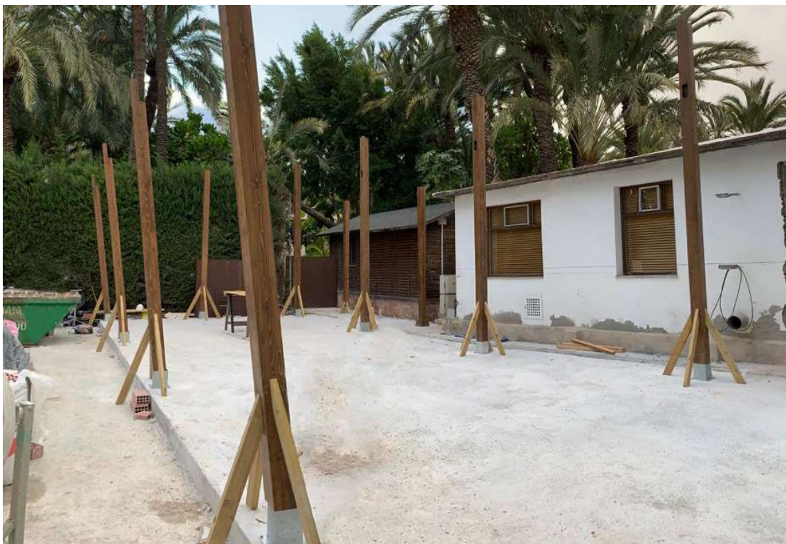
Ilustración 97: Secuencia de montaje. Pilares apuntalados. Imagen de obra.
