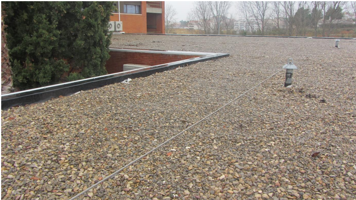
Ilustración 6. Cubierta del edificio
