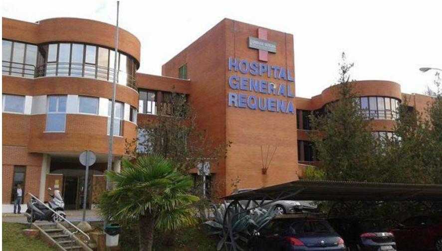
Ilustración 2. Entrada principal del Hospital (Oeste)
