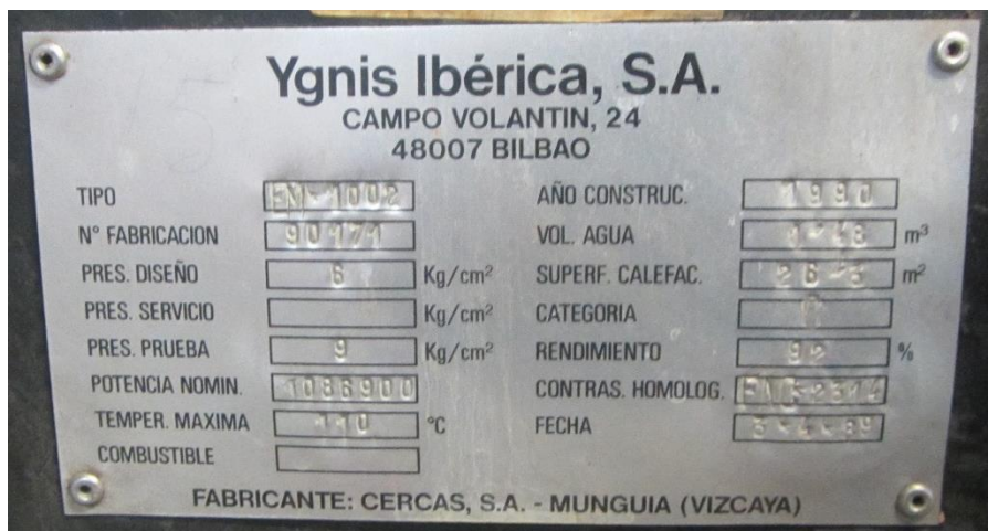
Ilustración 8. Datos técnicos caldera tipo EM-1002
