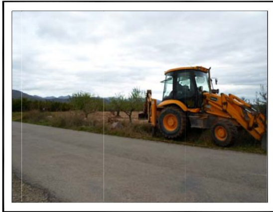
EMPLAZAMIENTO, ACOPIO DE CALICATA
