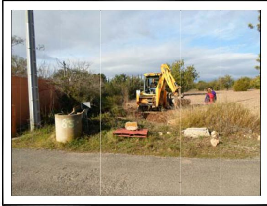
EMPLAZAMIENTO, ACOPIO DE CALICATA
