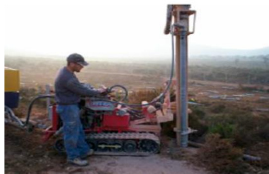
Estructura portante instalación FV y Maquina perforadora
