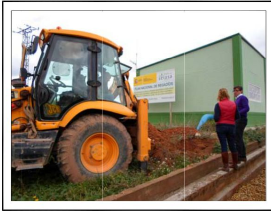
EMPLAZAMIENTO, ACOPIO DE CALICATA
