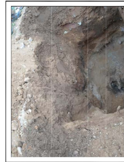
FOTOGRAFÍA DE CALICATA
