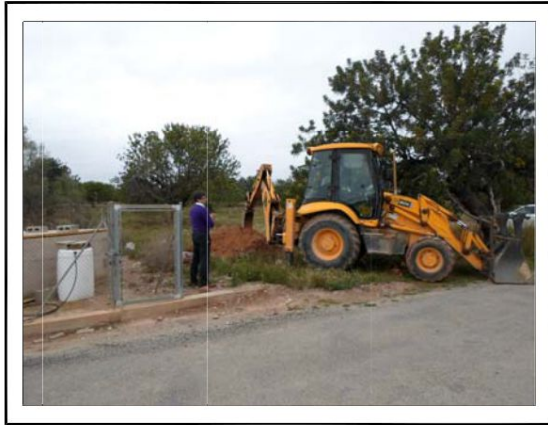
EMPLAZAMIENTO, ACOPIO DE CALICATA
