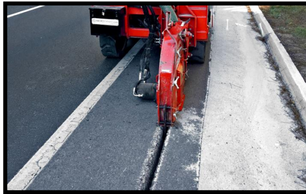
Corte de firmes asfálticos
