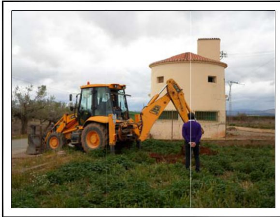
EMPLAZAMIENTO, ACOPIO DE CALICATA
