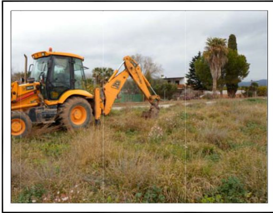
EMPLAZAMIENTO, ACOPIO DE CALICATA
