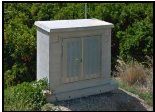
Caseta Prefabricada para Hidrantes Multiusuario
