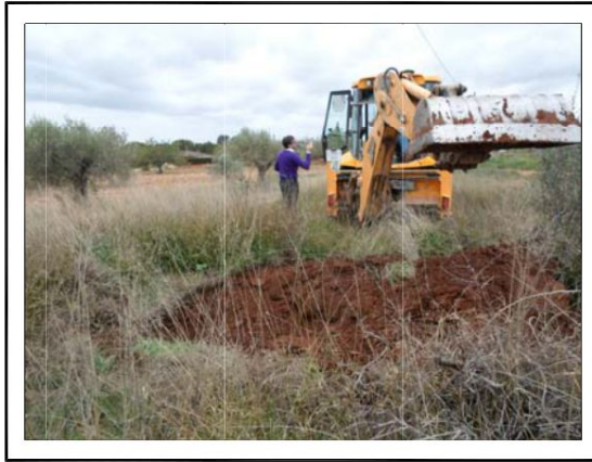
EMPLAZAMIENTO, ACOPIO DE CALICATA
