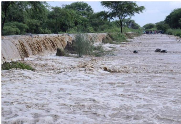
**Figura 10** Rotura en el dique izquierdo Sector Las Ánimas Pedregal – Bajo Piura
