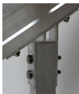
Detalle unión pata-viga
