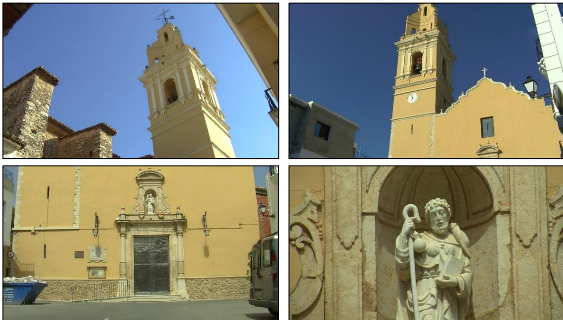
Figura 9 - Imágenes actuales de la fachada del templo. Fotografías realizadas por Emilio LLorens
